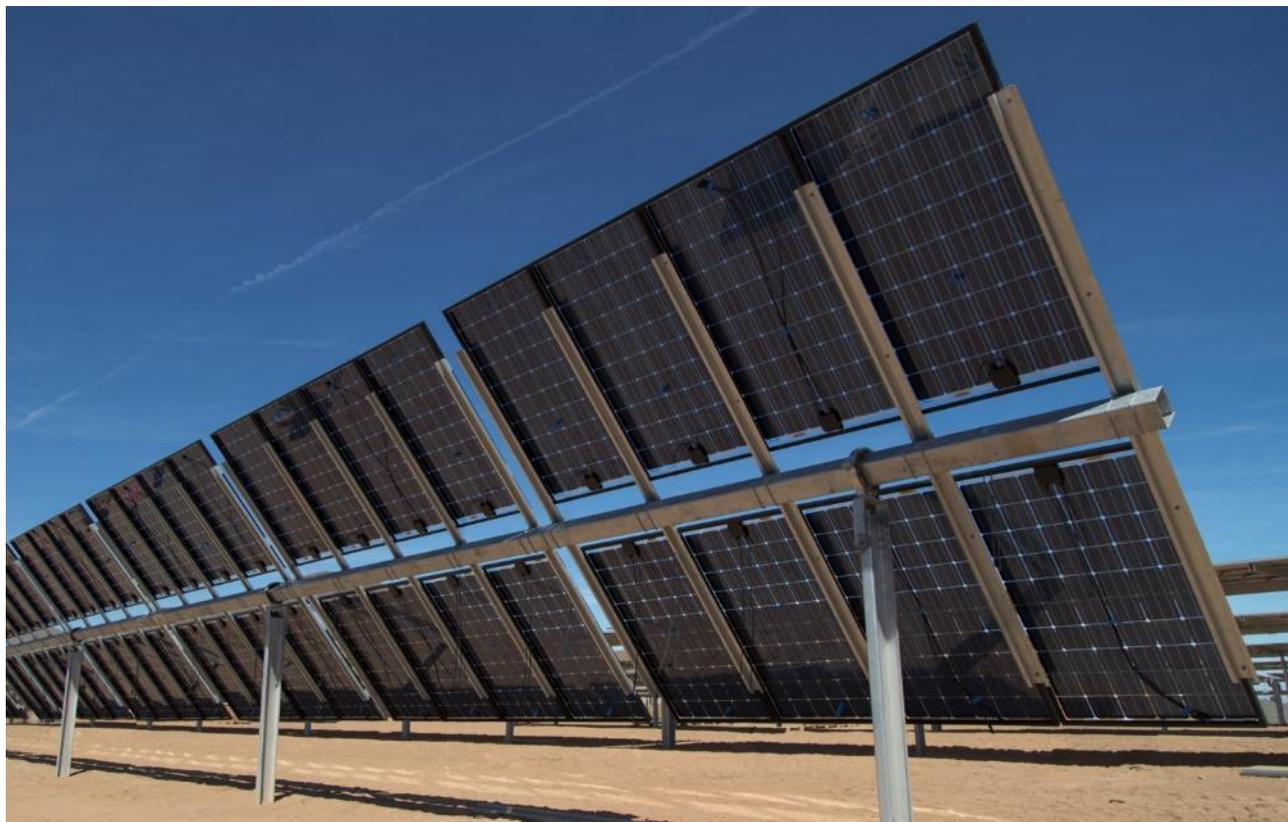
*Figura 5: Esempio struttura e modulo FV bifacciale*
