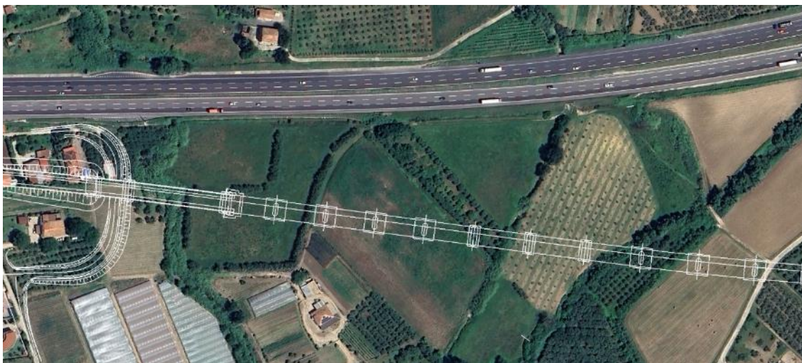
Area di intervento ante operam
