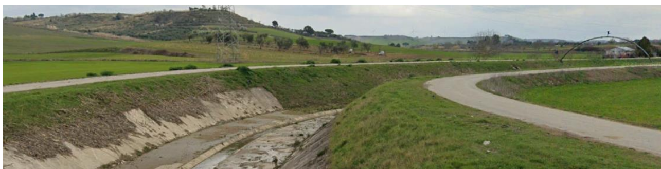
Figura 4.7 - L'alveo regimato del Torrente di Gravina di Matera.
