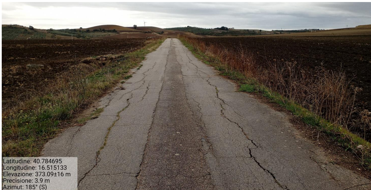
Figura 4.28 – Viabilità rurale esistente di collegamento alla postazione S6 (direzione sud).
