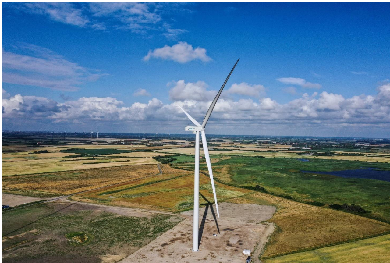
Figura 2.3 – Aerogeneratore tipo SG 6.6-170
