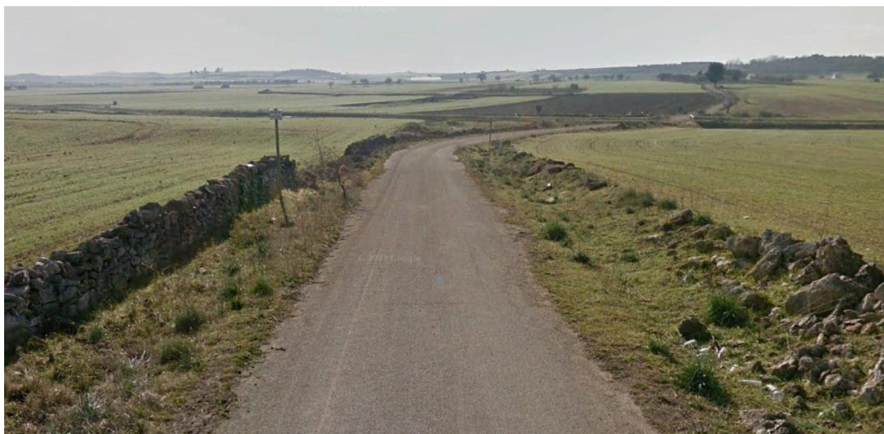
Figura 4.19 – Viabilità da adeguare di accesso alla postazione eolica S4 (direzione sud-ovest)
