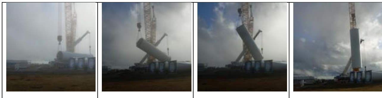
Figura 4.36 – Schema delle fasi di sollevamento dei componenti dell'aerogeneratore (Fonte sito web http://www.windfarmbop.com/ )
