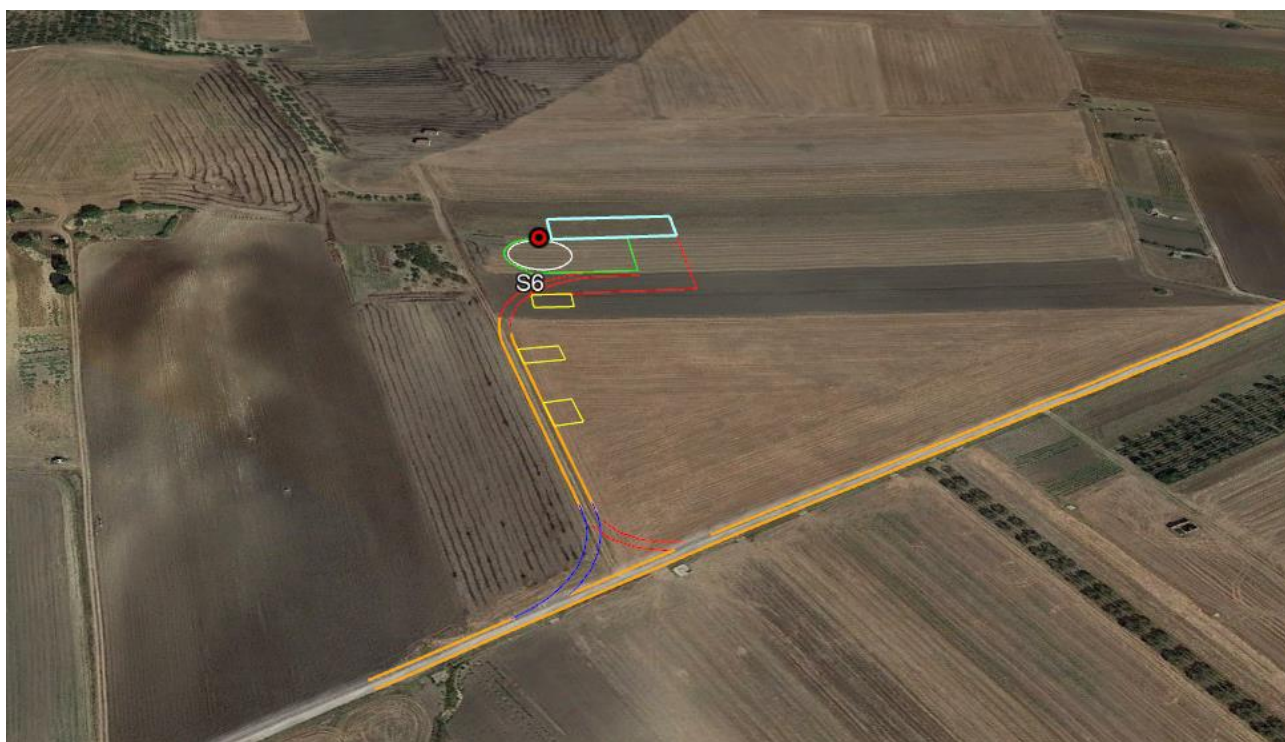
Figura 5.8 – Percorso di accesso alla postazione eolica S6 (vista verso ovest)
