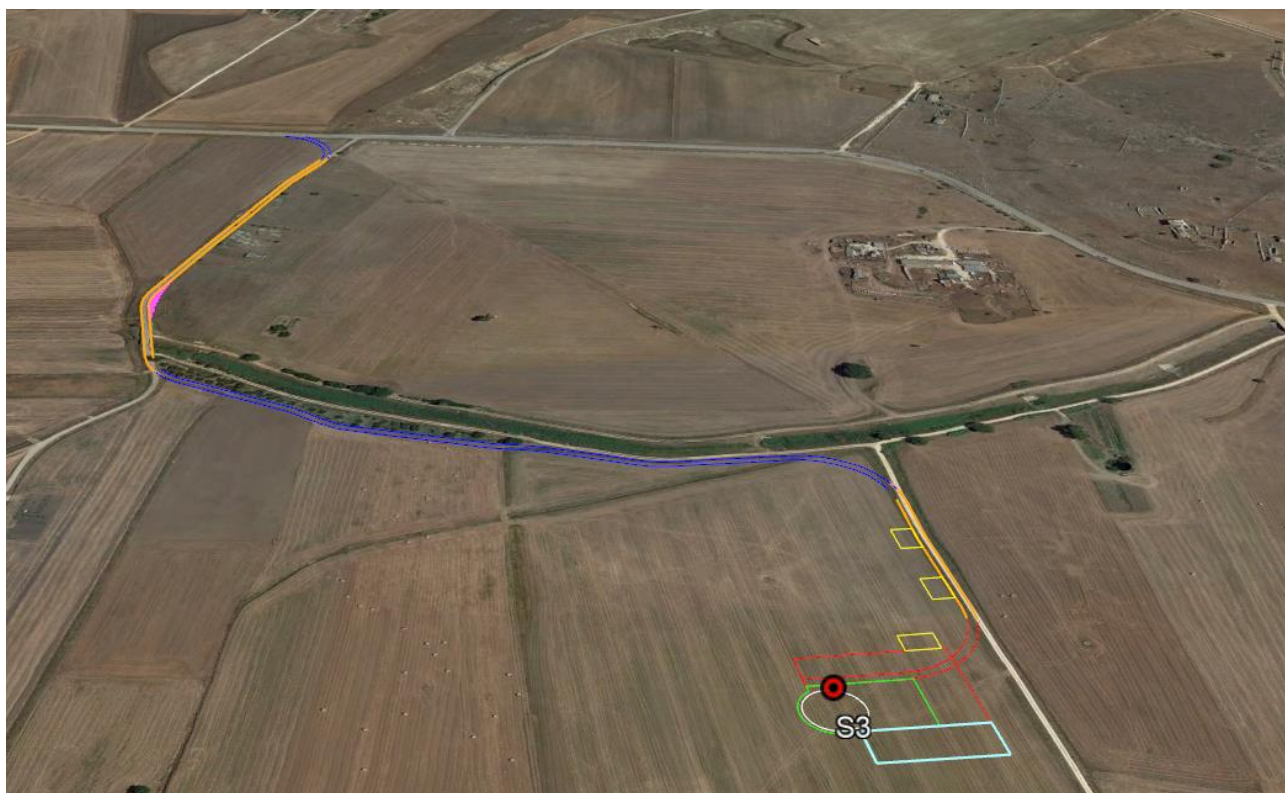
Figura 5.5 – Tracciato di collegamento alla postazione eolica S3 (vista verso nord-est).
