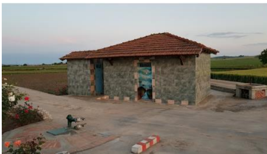
Figura 6.2 – Edificio F131 (locale tecnico presso il punto di derivazione idrico denominato “Sorgente Serra di Mele”)
