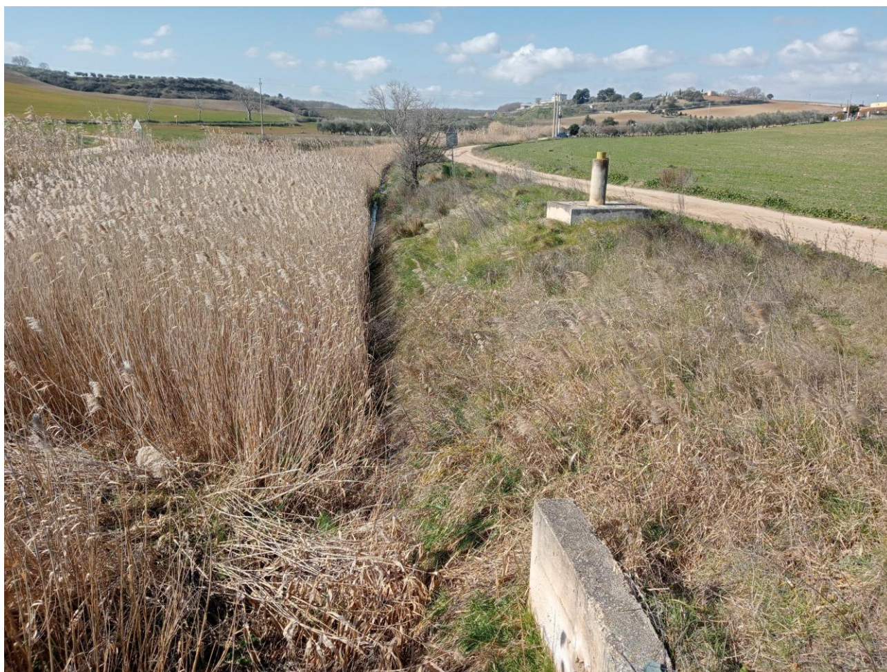
Figura 6.7- Ripresa fotografica del torrente a valle dell'invaso Sagliocchia.
