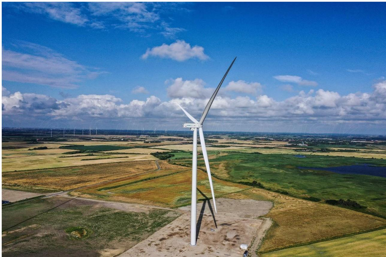
Figura 4.3 – Aerogeneratore tipo SG 6.6-170
