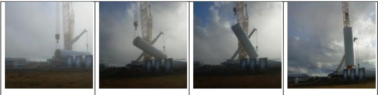
Figura 4.39 – Schema delle fasi di sollevamento dei componenti dell'aerogeneratore (Fonte sito web <http://www.windfarmbop.com/> )
