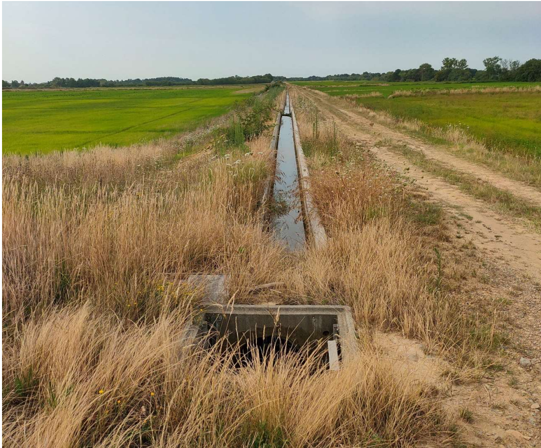
FIGURA 5-1: CANALE IRRIGUO ESISTENTE
