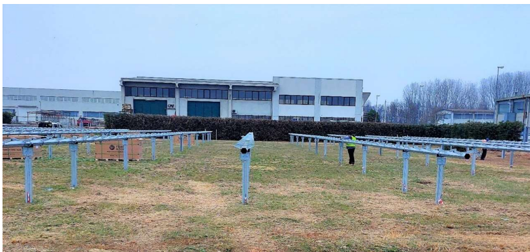
FIGURA 10-2: PALI INFISSI E TRACKER
