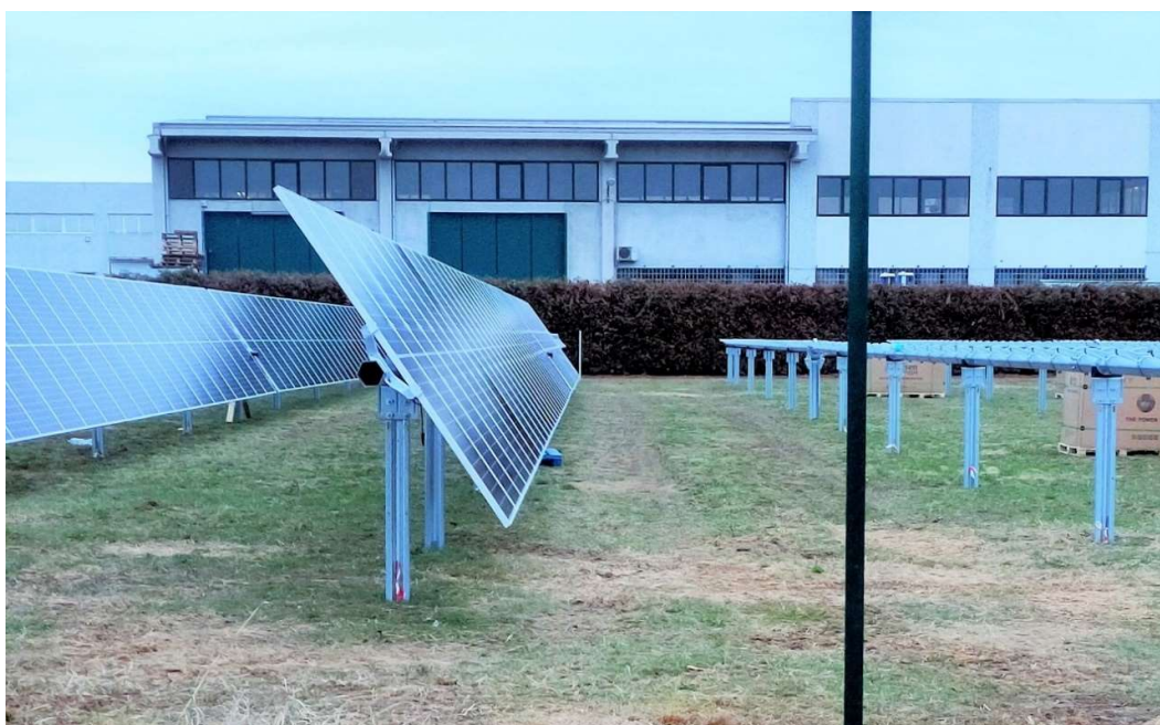
FIGURA 10-3: FASE DI INSTALLAZIONE DEI PANNELLI
