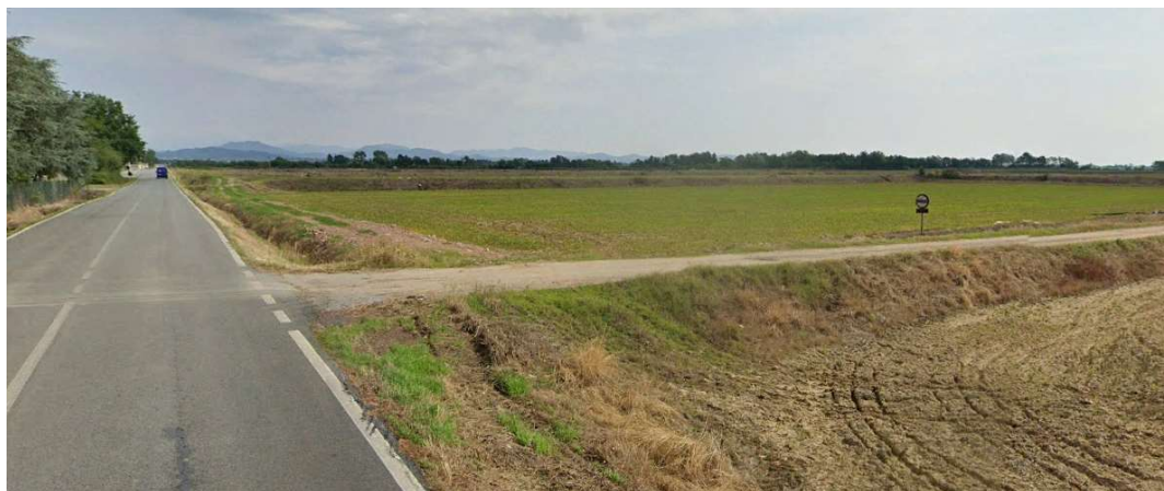
FIGURA 10-4: ACCESSO ESISTENTE SULLA SP315 (VERSO NORD), AD OVEST DEL SITO, RITENUTO NON IDONEO AL TRANSITO DEI MEZZI PESANTI DI CANTIERE
