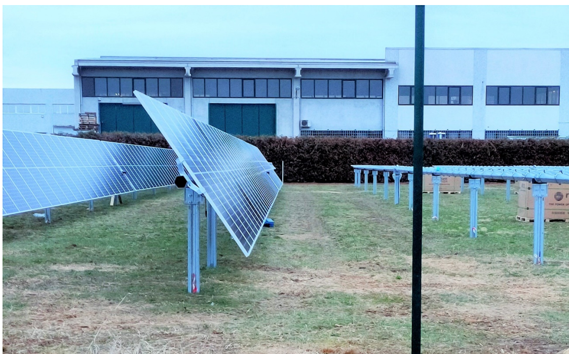
FIGURA 3-3: FASE DI INSTALLAZIONE DEI PANNELLI
