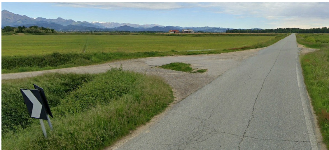
FIGURA 2-3: ACCESSO ESISTENTE SULLA SP316 (VERSO NORD), AD EST DEL SITO, RITENUTO IDONEO AL TRANSITO DEI MEZZI PENSANTI DI CANTIERE
