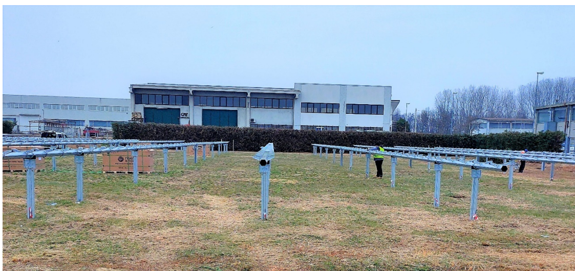
FIGURA 3-2: PALI INFISSI E TRACKER
