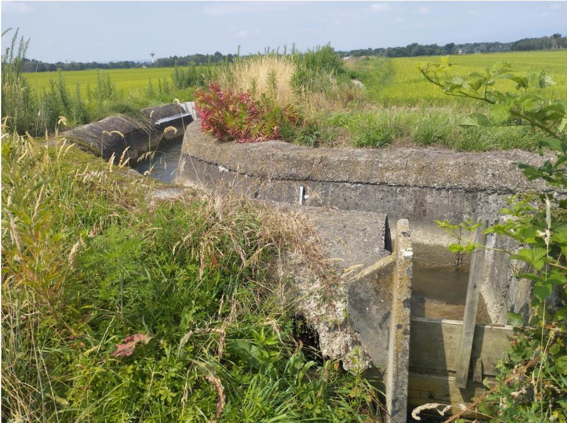
**FIGURA 6 CANALE CONSORTILE CON BOCCHETTO DI DERIVAZIONE**
