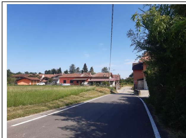
Figura 31 – Sterrata su cui insisterà il cavidotto, ripresa da S
