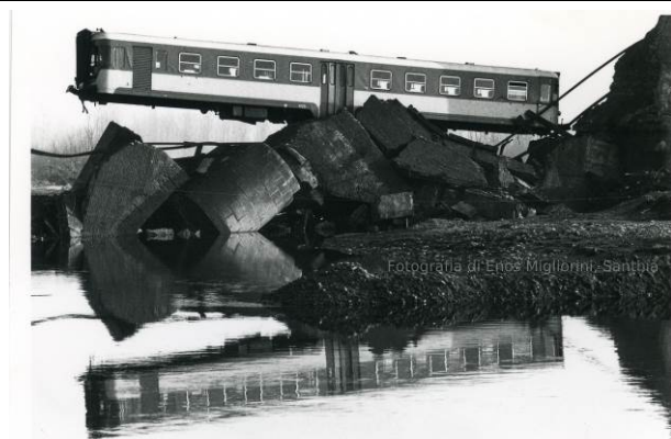
Figura 38 –Foto d'epoca crollo ponte ferroviario
