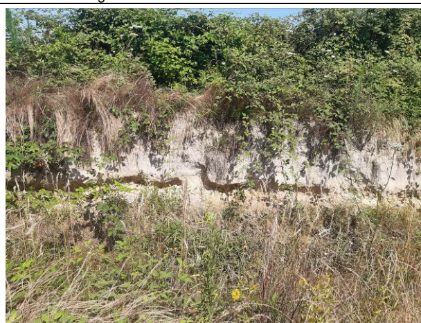
Figura 24 – Finestra stratigrafica su strada
