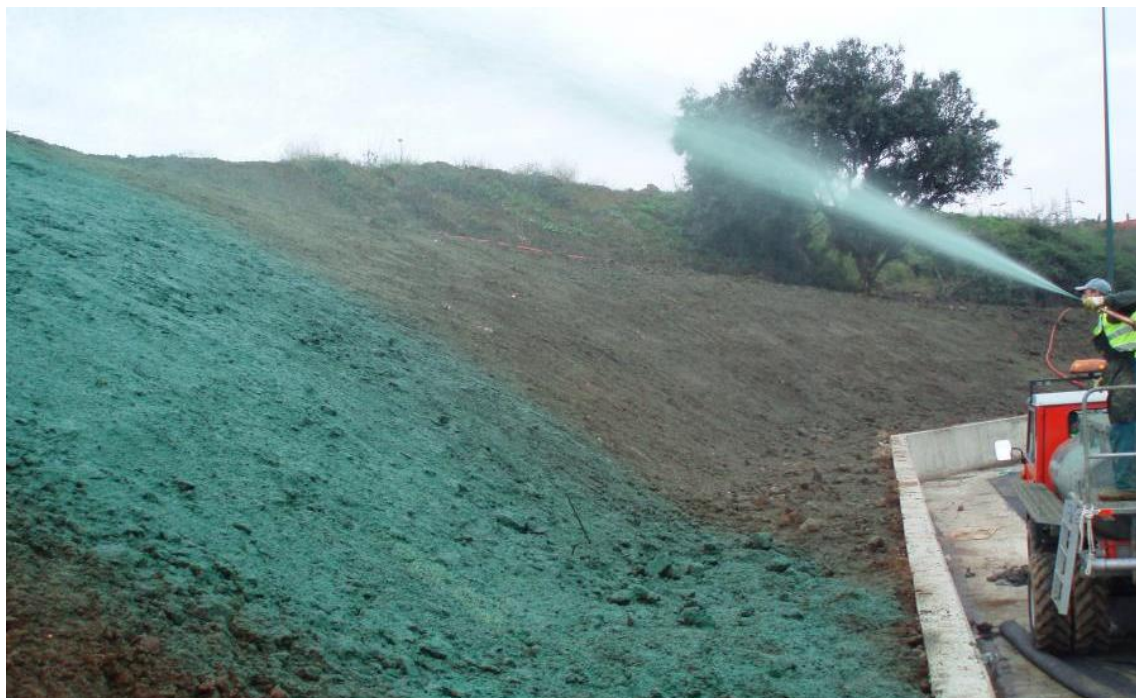
Figura 26 - Esempi di applicazioni di idrosemina
