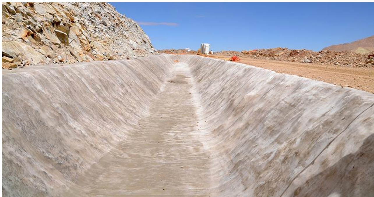
Figura 30 - Esempio di fosso di guardia in terra
