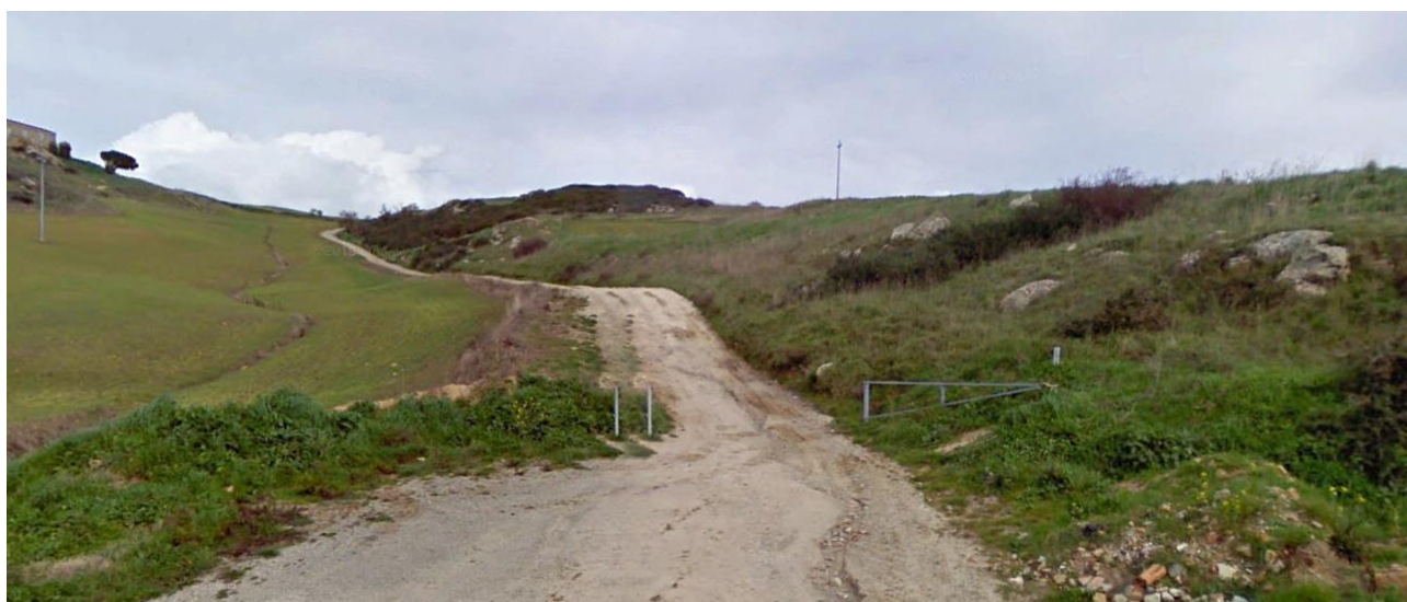
Figura 22 - Viabilità di accesso alla WTG 6
