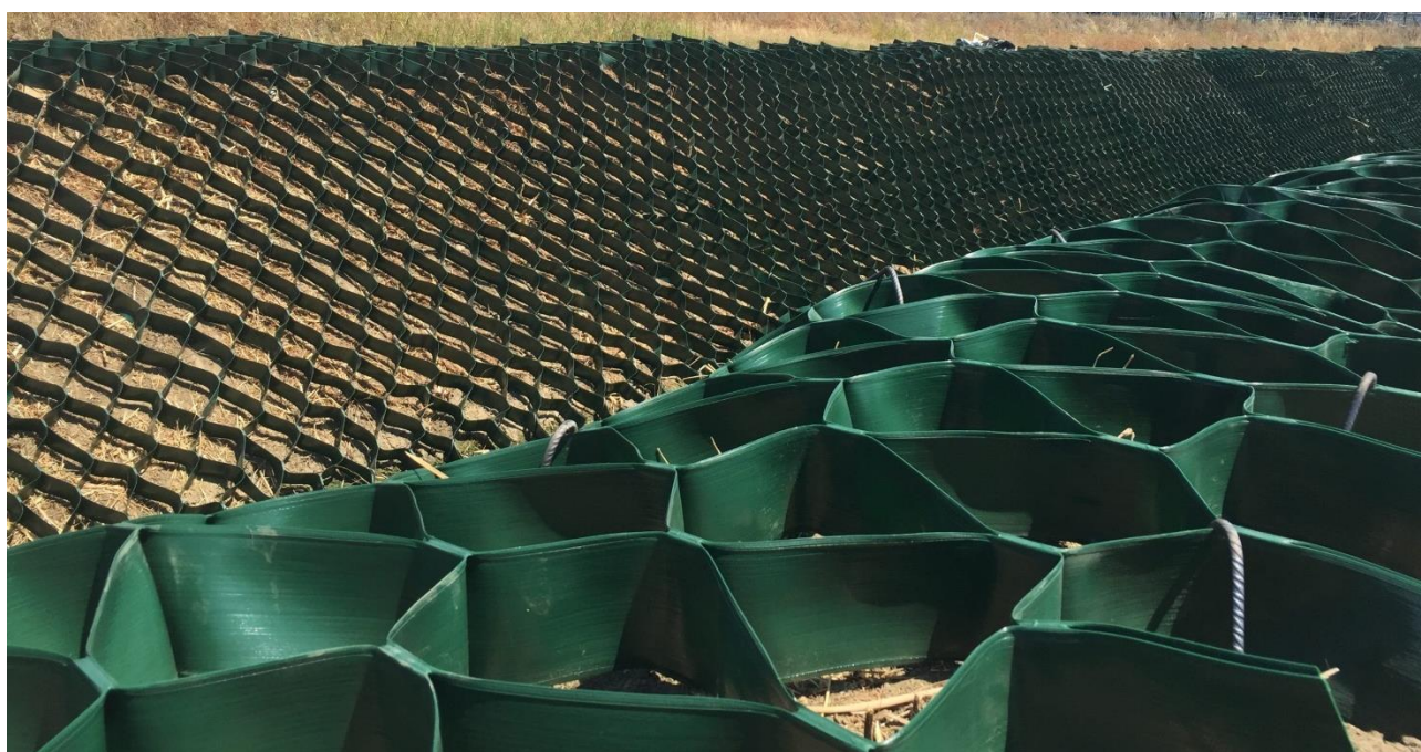
Figura 29 - Esempio di applicazioni con geocelle
