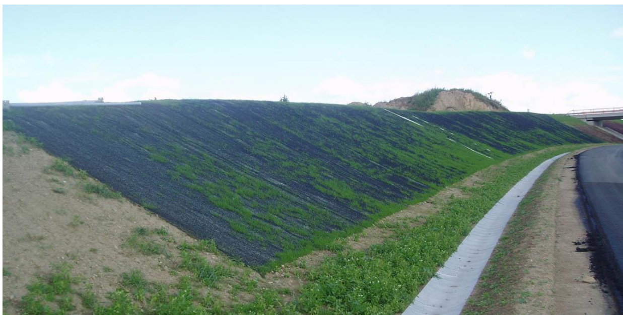
Figura 27 - Esempi di applicazioni di geostuoie
