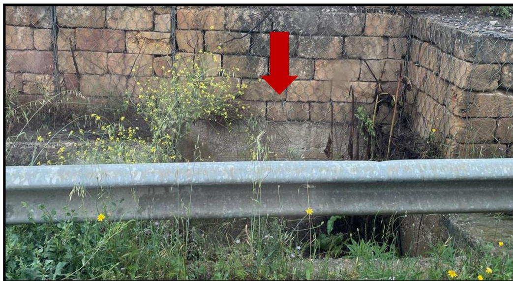
Figura 47 - foto dell'impluvio costituente l'interferenza "Int.46"
