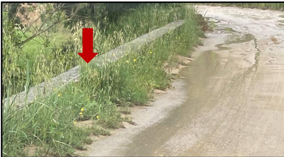
Figura 12 - foto dell'impluvio costituente l'interferenza "Int. 11"
