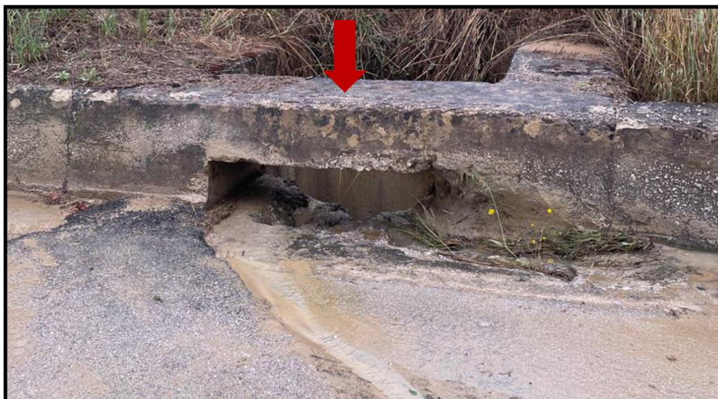
Figura 26 - foto dell'impluvio costituente l'interferenza "Int.25"
