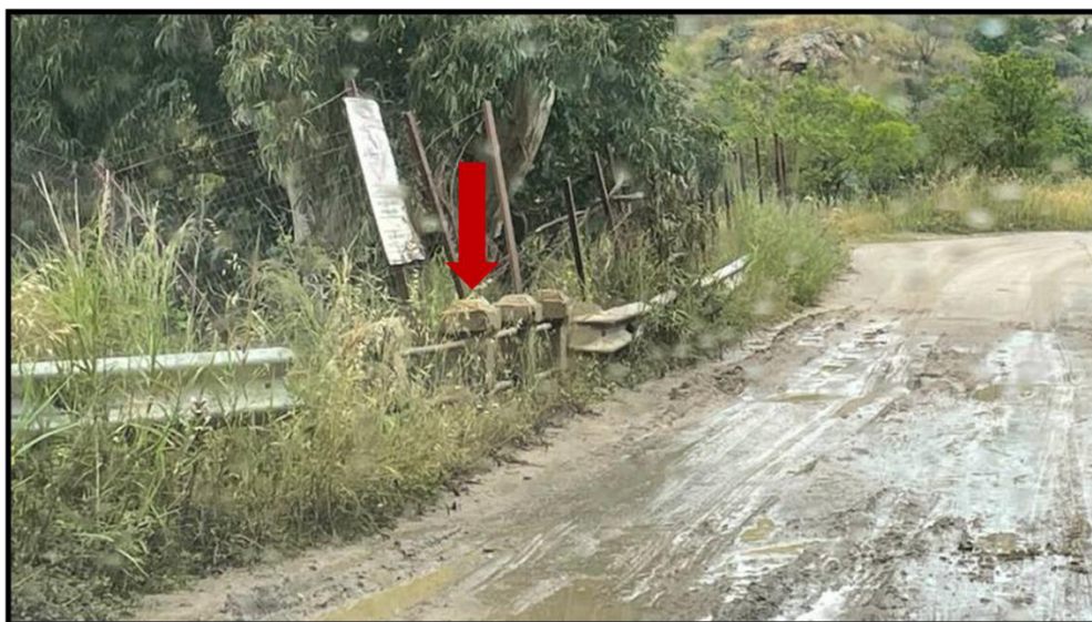
Figura 7 - foto dell'impluvio costituente l'interferenza “Int.6”
