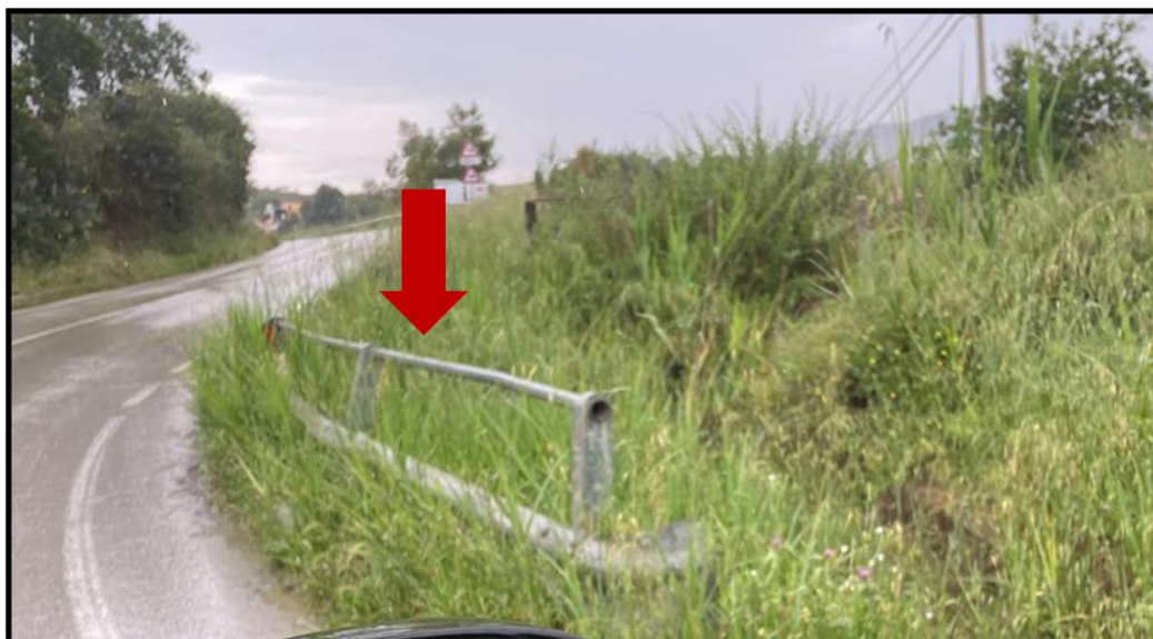
Figura 31 - foto dell'impluvio costituente l'interferenza "Int.30"
