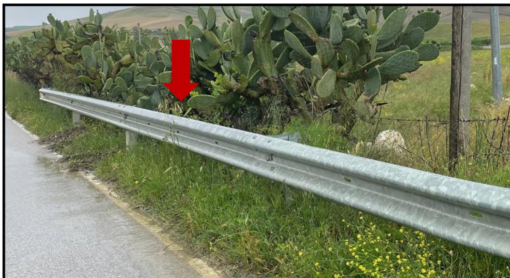
Figura 37 - foto dell'impluvio costituente l'interferenza "Int.36"
