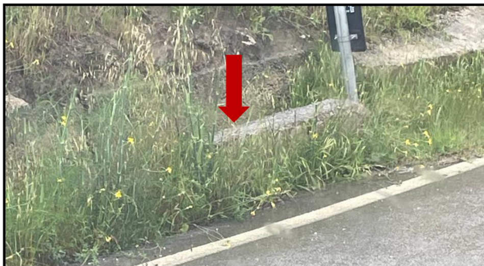
Figura 35 - foto dell'impluvio costituente l'interferenza "Int.34"
