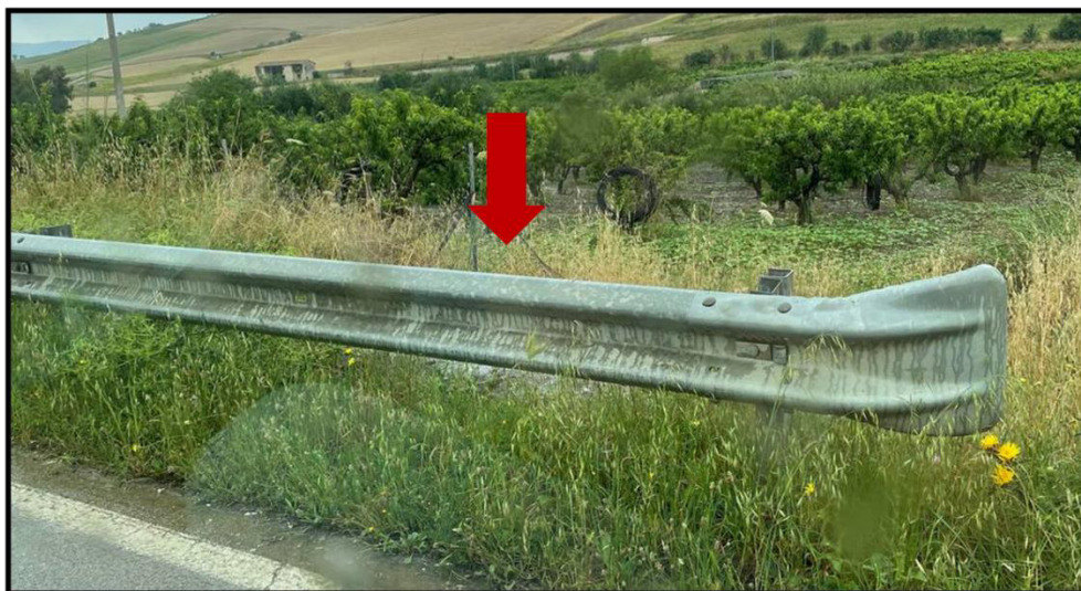
Figura 41 - foto dell'impluvio costituente l'interferenza "Int.40"
