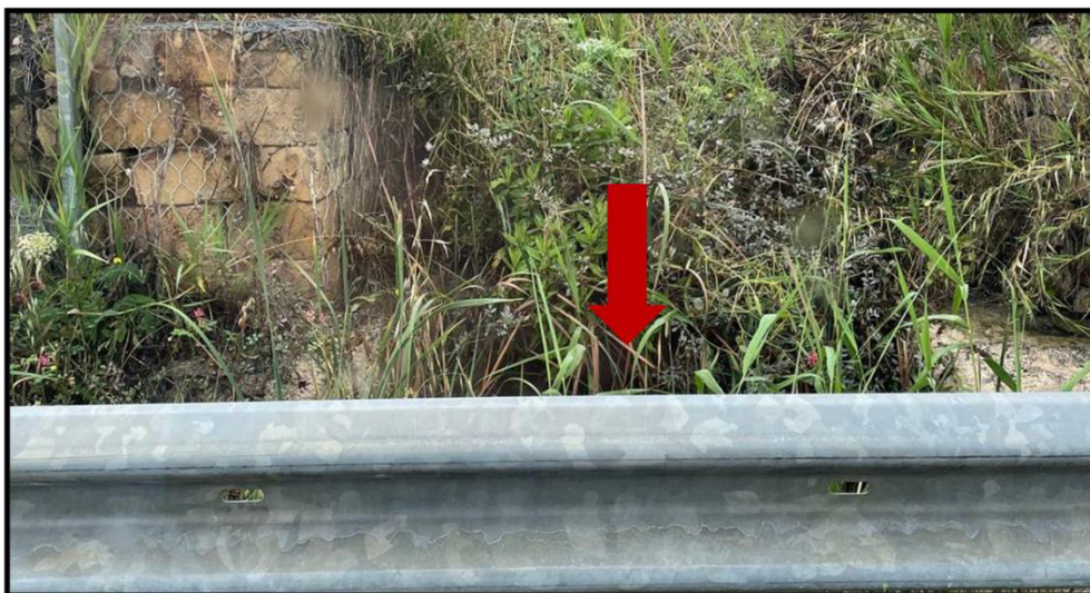
Figura 48 - foto dell'impluvio costituente l'interferenza "Int.47"
