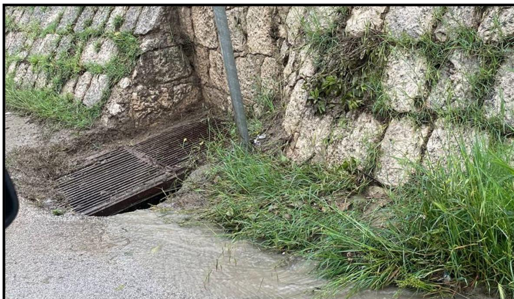
Figura 30 - foto dell'impluvio costituente l'interferenza "Int.29"
