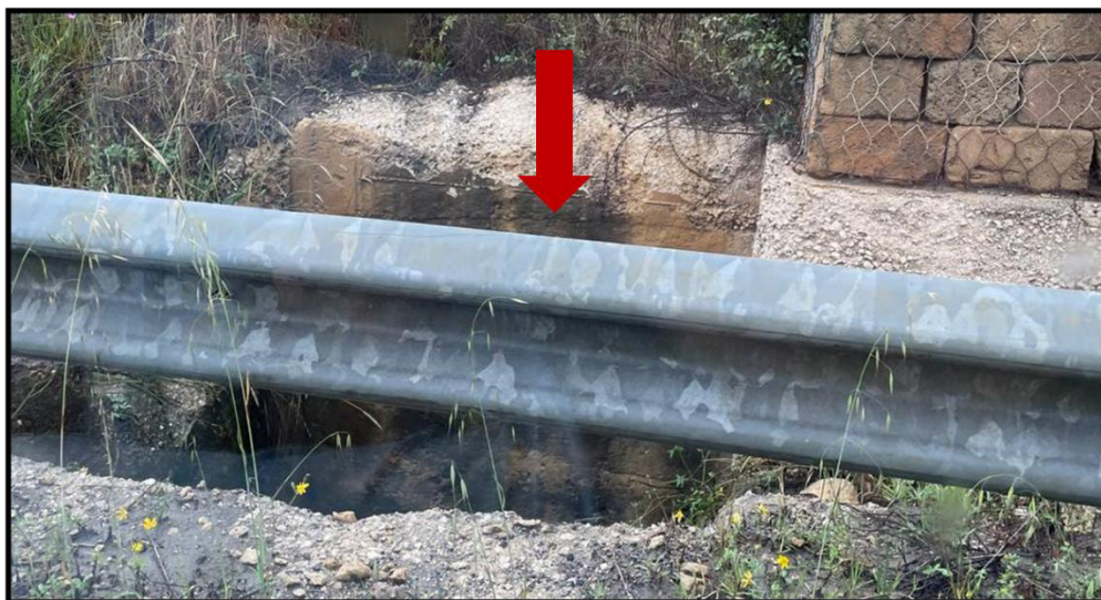
Figura 51 - foto dell'impluvio costituente l'interferenza “Int.50”
