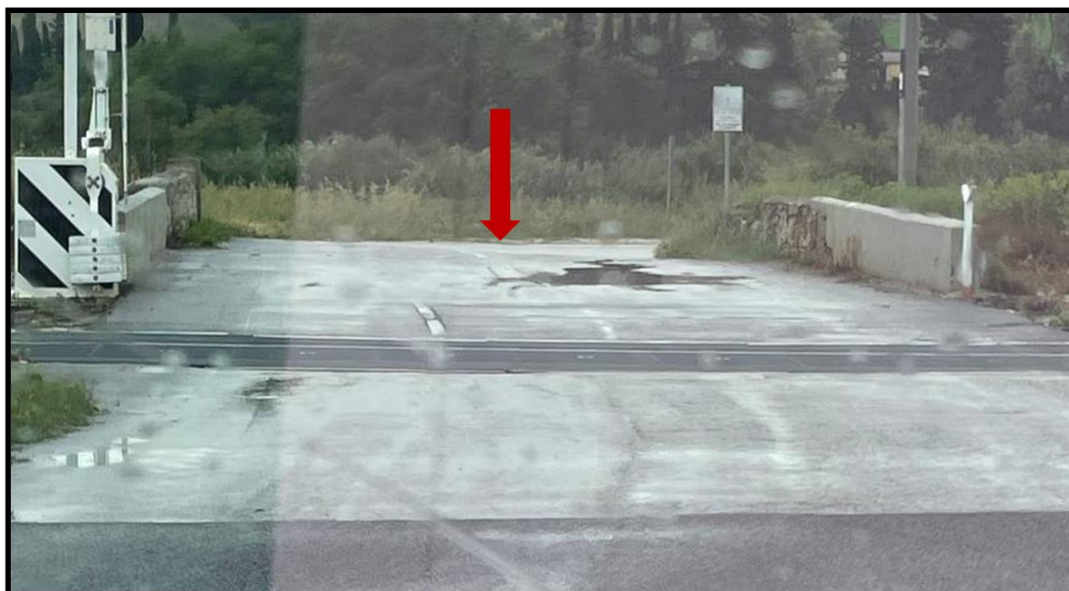
Figura 18 - foto dell'impluvio costituente l'interferenza "Int. 17"
