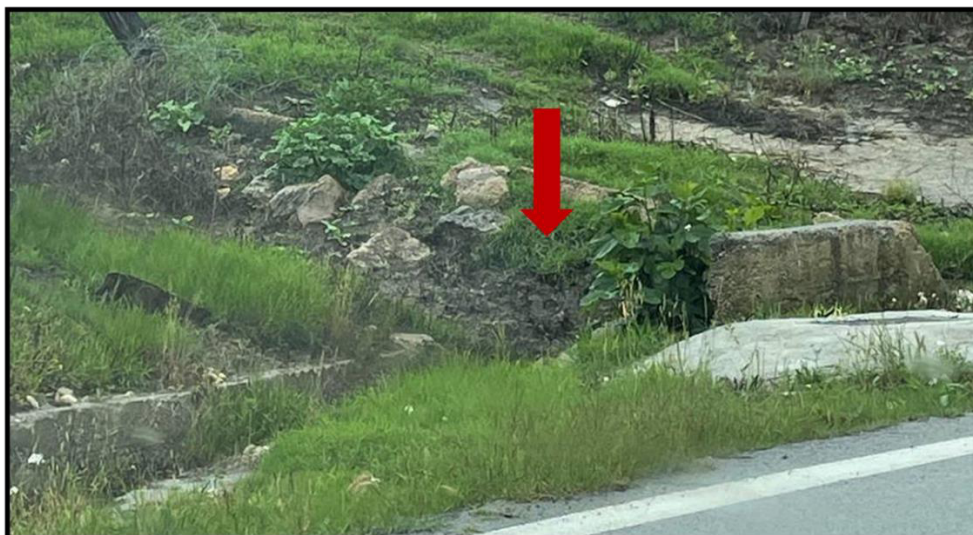
Figura 34 - foto dell'impluvio costituente l'interferenza "Int.33"
