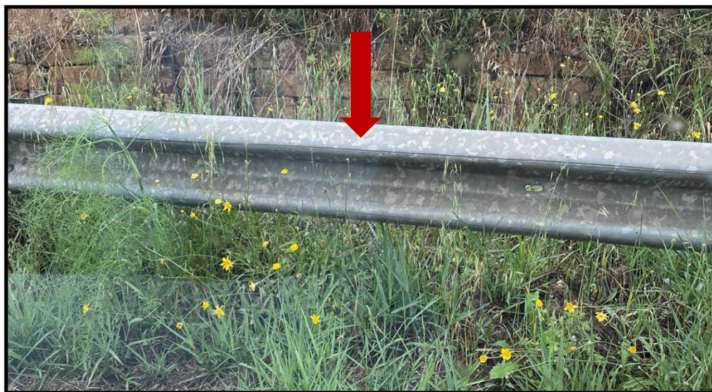
Figura 53 - foto dell'impluvio costituente l'interferenza "Int.52"
