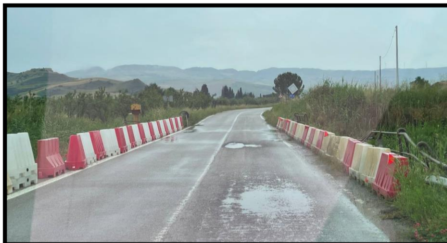
Figura 21 - foto dell'impluvio costituente l'interferenza "Int. 20"
