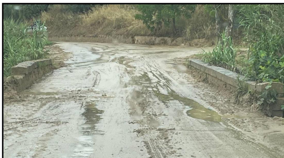
Figura 11 - foto dell'impluvio costituente l'interferenza "Int. 10"
