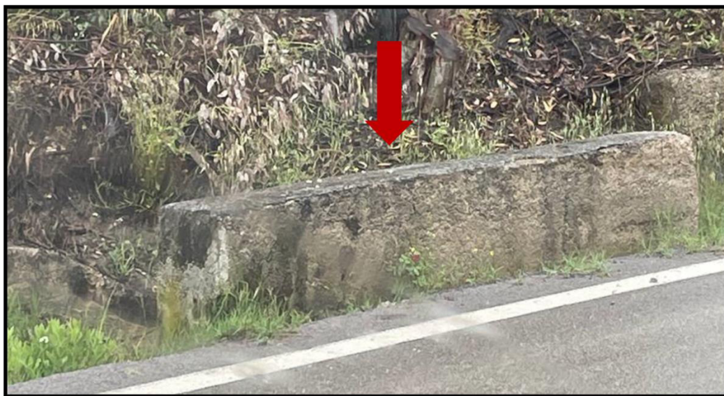
Figura 33 - foto dell'impluvio costituente l'interferenza "Int.32"
