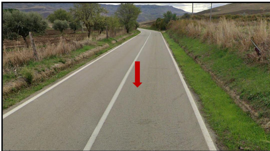
Figura 69 - foto dell'impluvio costituente l'interferenza "Int.57"
