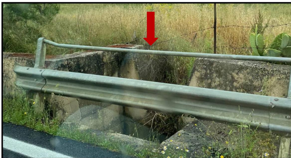
Figura 43 - foto dell'impluvio costituente l'interferenza "Int.42"
