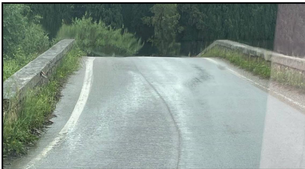
Figura 19 - foto dell'impluvio costituente l'interferenza "Int. 18"
