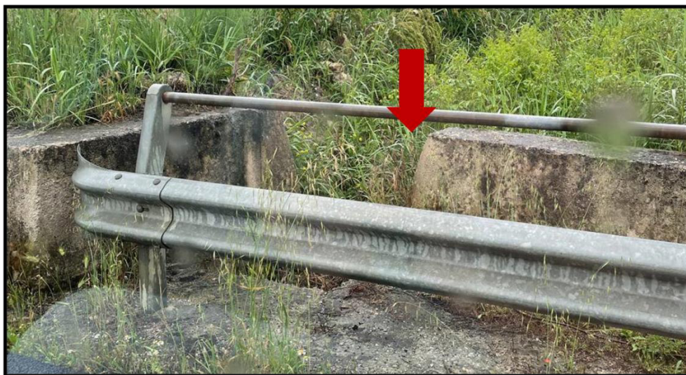
Figura 44 - foto dell'impluvio costituente l'interferenza "Int.43"
