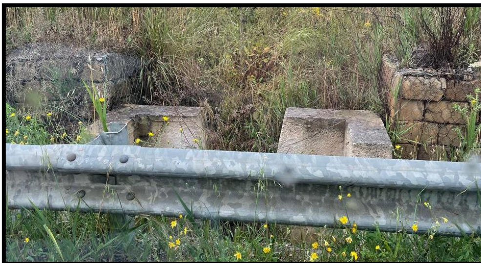
Figura 50 - foto dell'impluvio costituente l'interferenza "Int.49"
