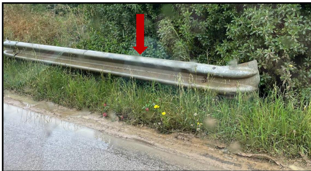
Figura 42 - foto dell'impluvio costituente l'interferenza "Int.41"
