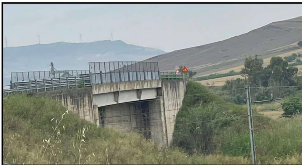
Figura 20 - foto dell'impluvio costituente l'interferenza "Int. 19"
