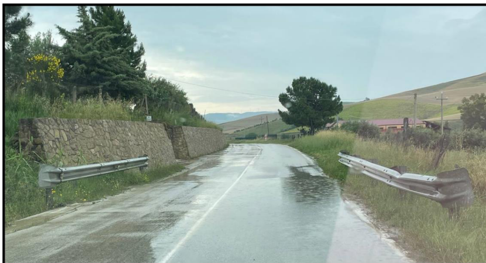
Figura 38 - foto dell'impluvio costituente l'interferenza "Int.37"
