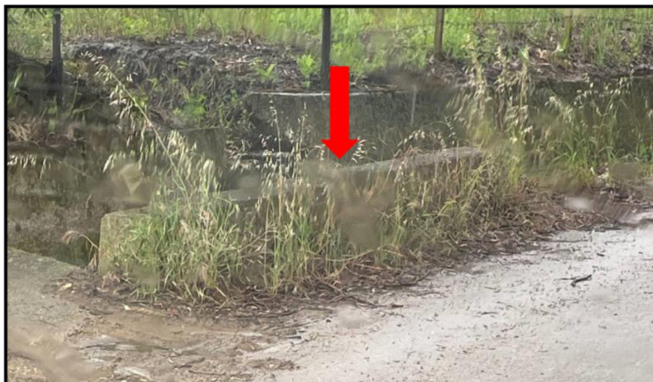
Figura 22 - foto dell'impluvio costituente l'interferenza "Int.21"
