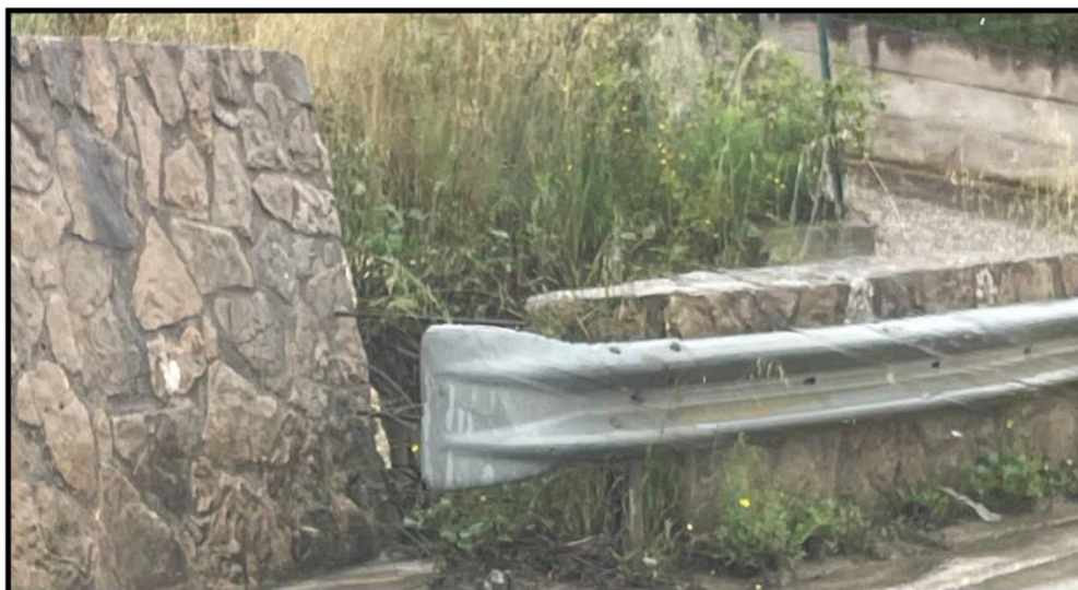
Figura 39 - foto dell'impluvio costituente l'interferenza "Int.38"
