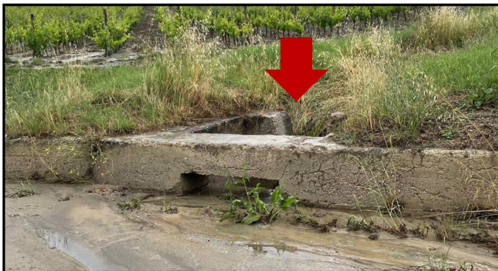
Figura 25 - foto dell'impluvio costituente l'interferenza "Int.24"
