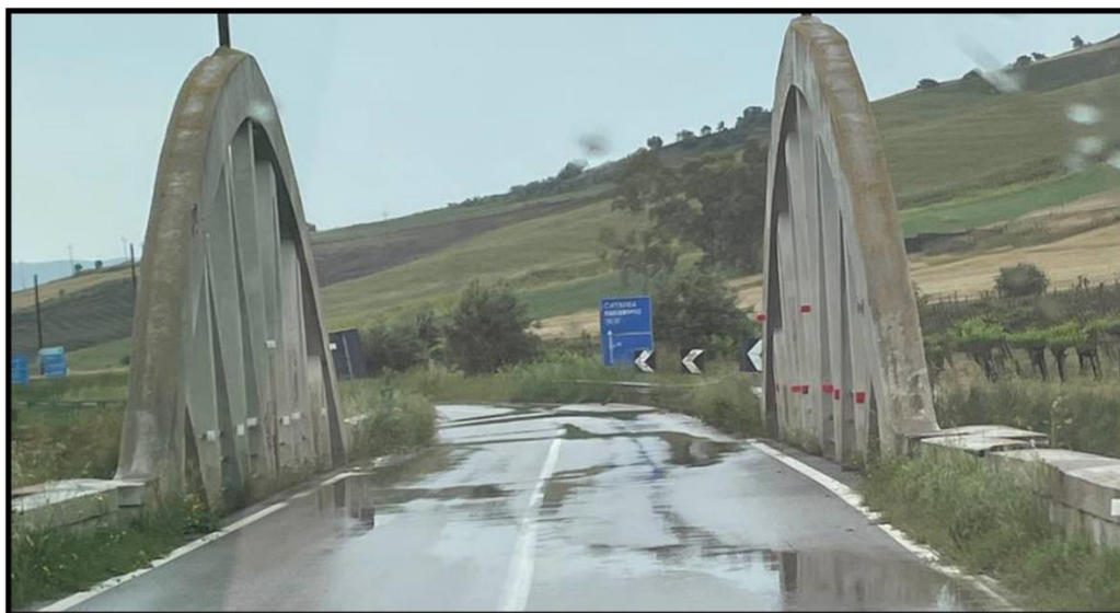
Figura 17 - foto dell'impluvio costituente l'interferenza "Int. 16"
