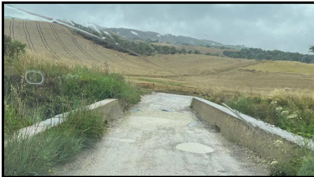
Figura 9 - foto dell'impluvio costituente l'interferenza "Int. 8"
