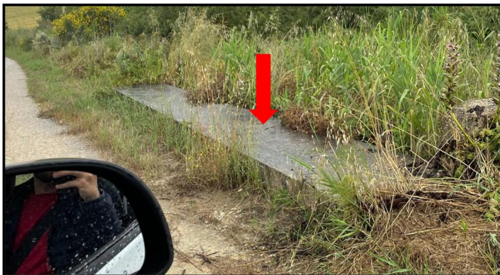
Figura 23 - foto dell'impluvio costituente l'interferenza "Int.22"
