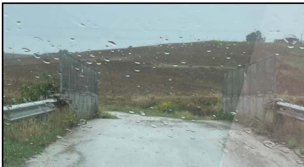
Figura 14 - foto dell'impluvio costituente l'interferenza "Int. 13"
