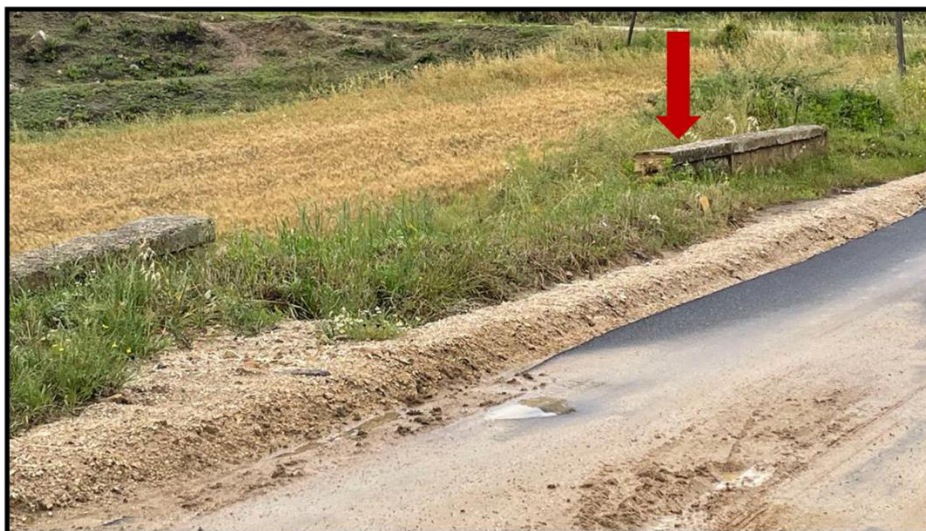
Figura 6 - foto dell'impluvio costituente l'interferenza “Int.5”
