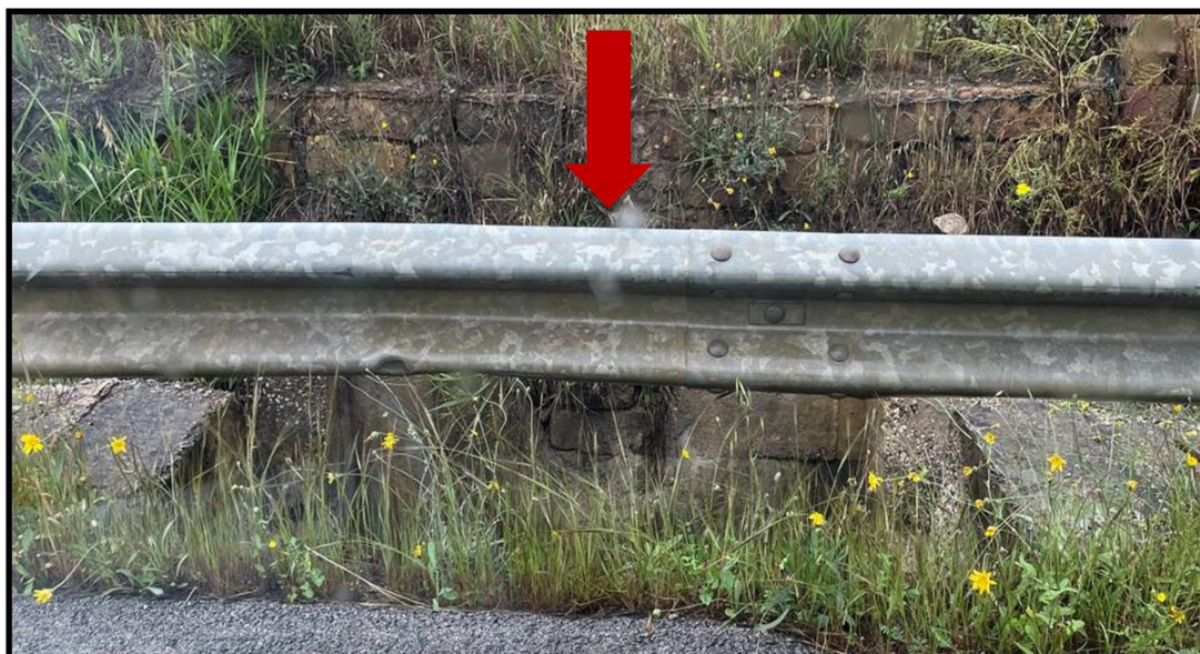
Figura 52 - foto dell'impluvio costituente l'interferenza "Int.51"
