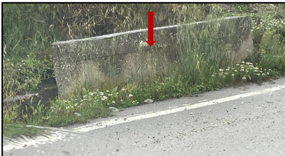
Figura 16 - foto dell'impluvio costituente l'interferenza "Int. 15"
