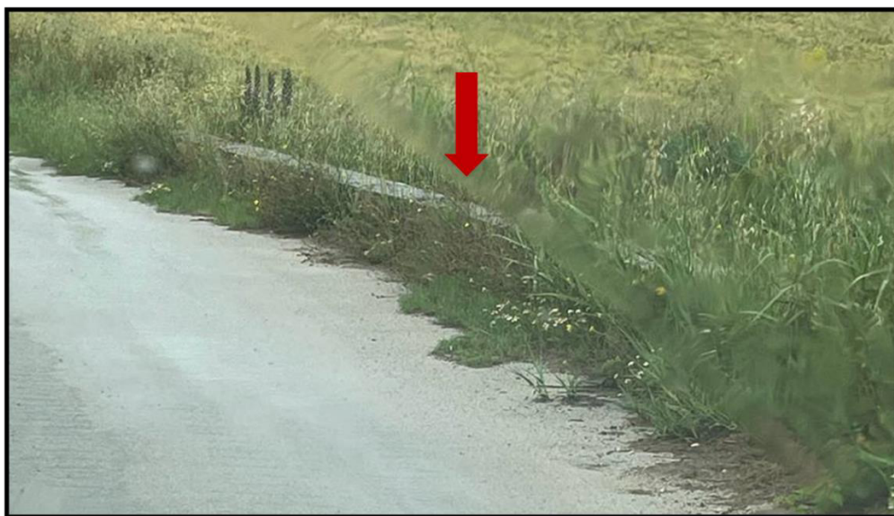
Figura 10 - foto dell'impluvio costituente l'interferenza "Int. 9"
