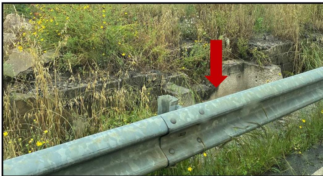
Figura 54 - foto dell'impluvio costituente l'interferenza "Int.53"
