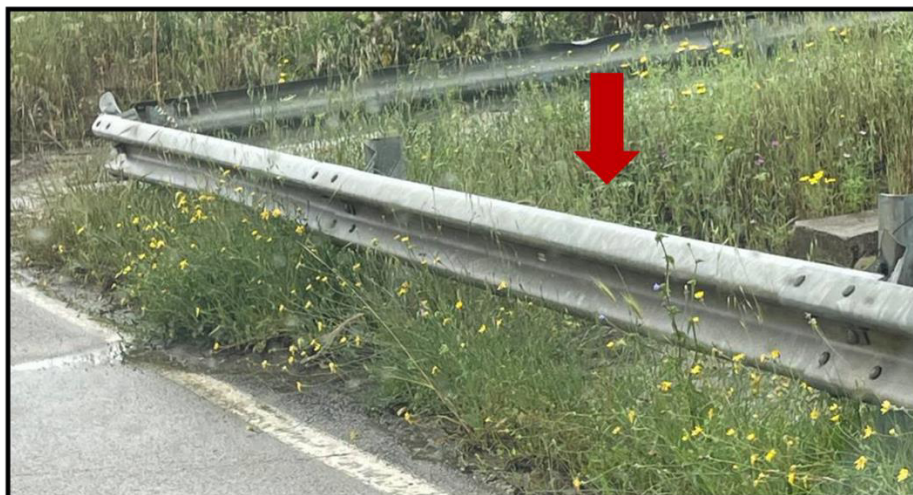
Figura 46 - foto dell'impluvio costituente l'interferenza "Int.45"
