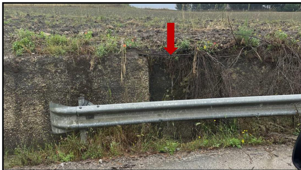
Figura 29 - foto dell'impluvio costituente l'interferenza "Int.28"
