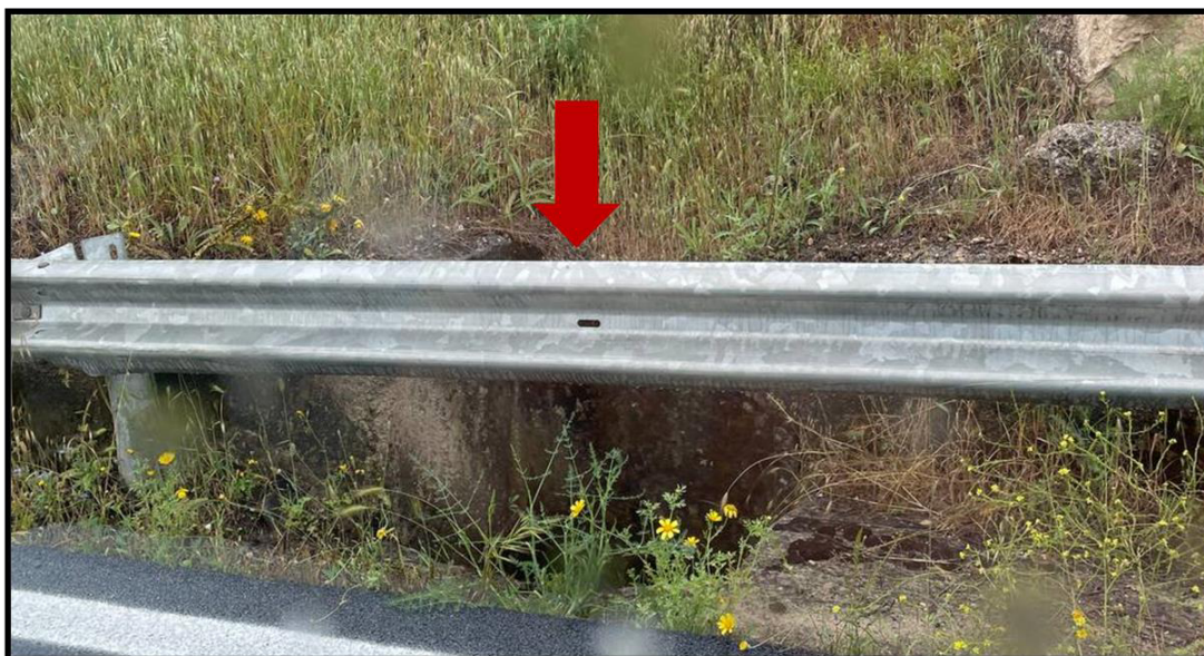
Figura 45 - foto dell'impluvio costituente l'interferenza “Int.44”
