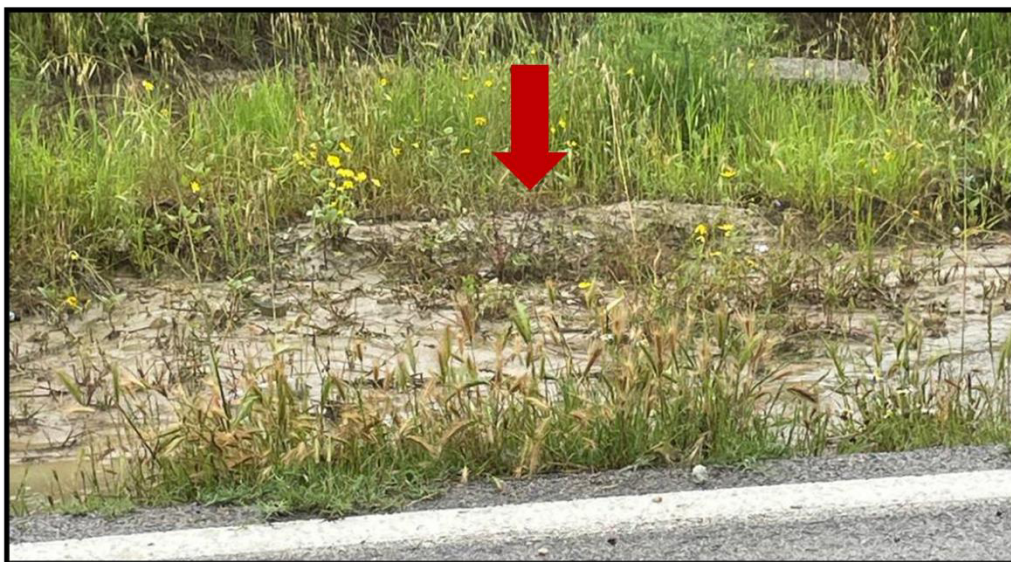
Figura 36 - foto dell'impluvio costituente l'interferenza "Int.35"
