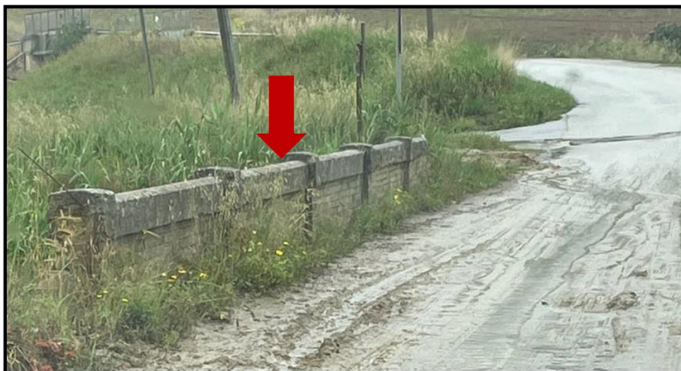
Figura 13 - foto dell'impluvio costituente l'interferenza "Int. 12"
