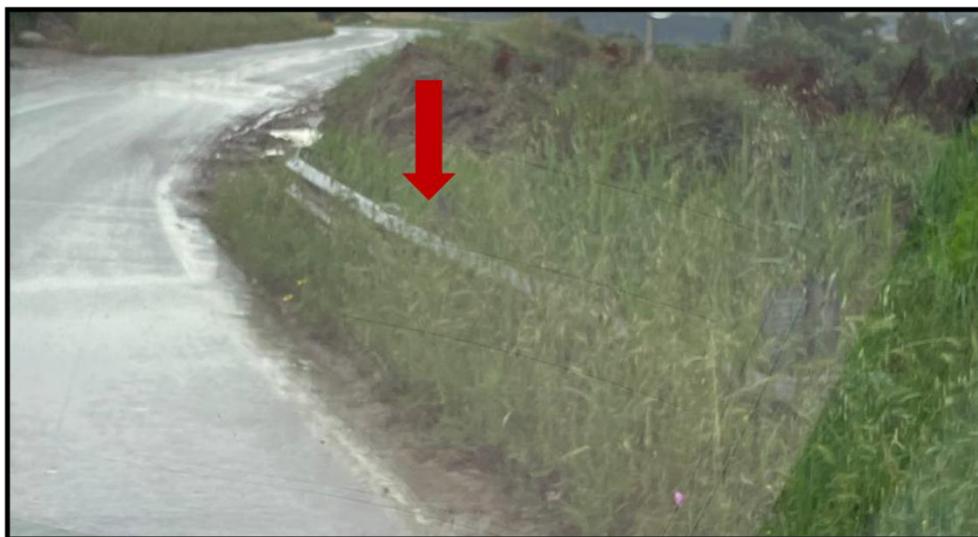
Figura 40 - foto dell'impluvio costituente l'interferenza "Int.39"
