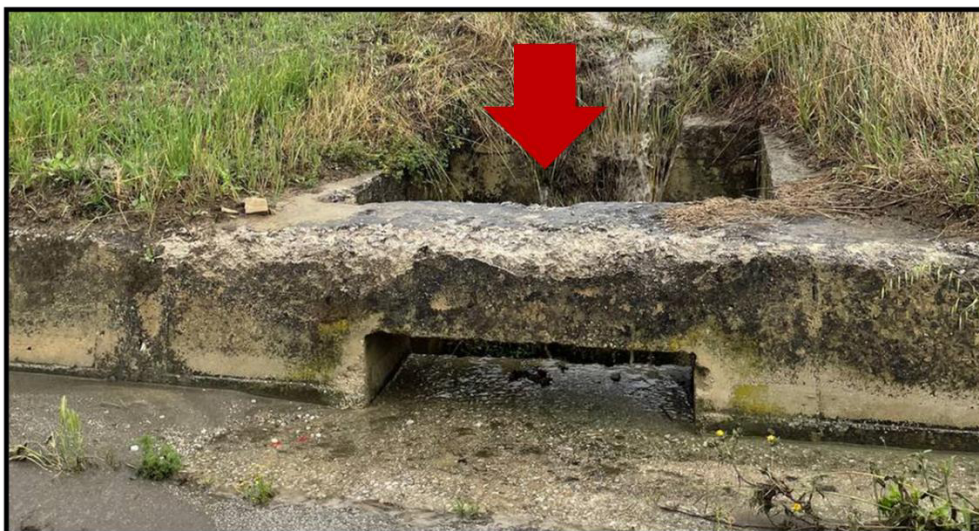
Figura 24 - foto dell'impluvio costituente l'interferenza "Int.23"
