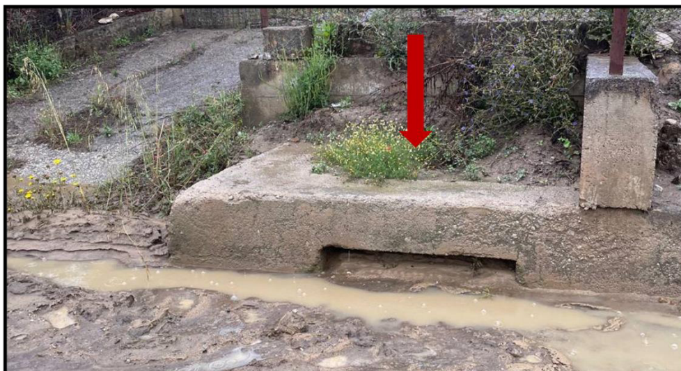
Figura 28 - foto dell'impluvio costituente l'interferenza "Int.27"
