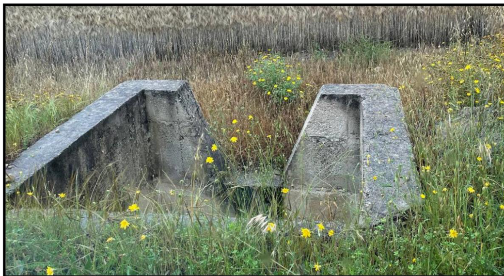
Figura 55 - foto dell'impluvio costituente l'interferenza "Int.54"
