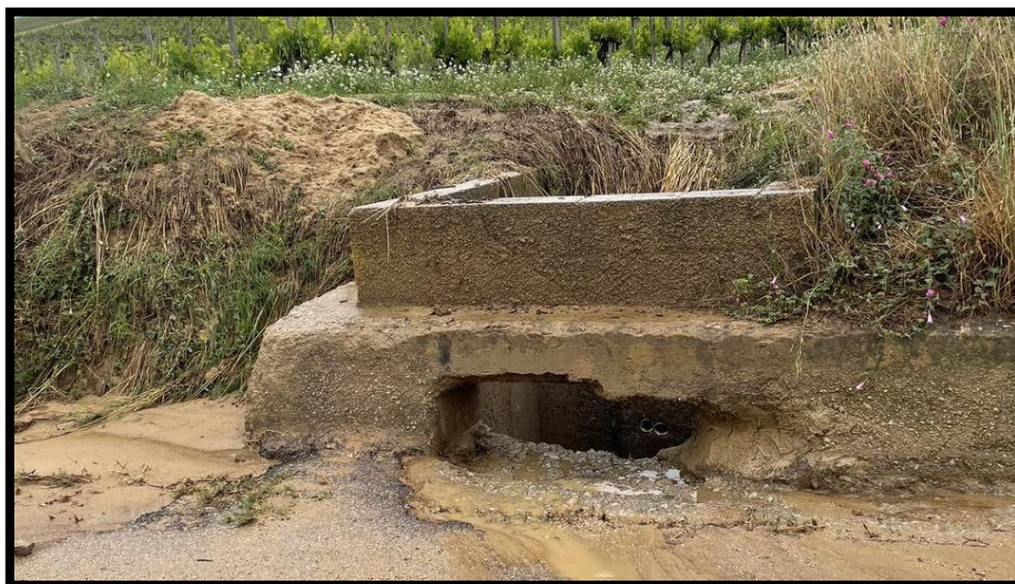
Figura 27 - foto dell'impluvio costituente l'interferenza "Int.26"
