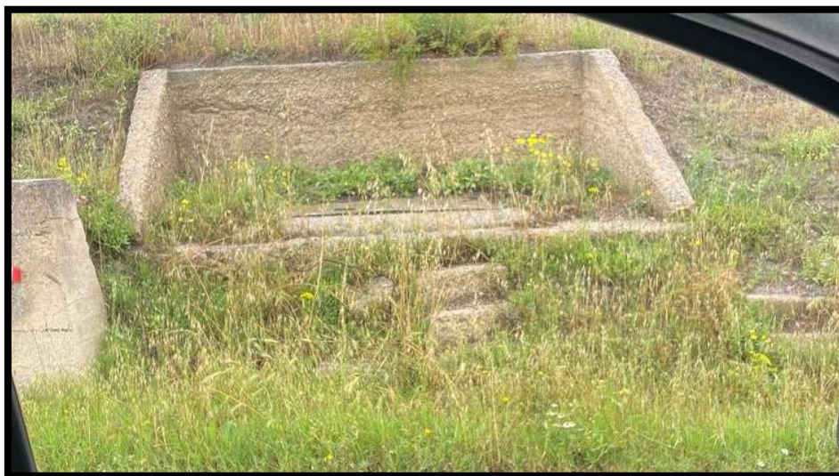
Figura 70 - foto dell'impluvio costituente l'interferenza “Int.56”
