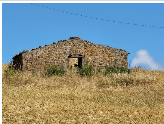
Fig. 12. Il casolare diruto nell'area della WTG 2.
