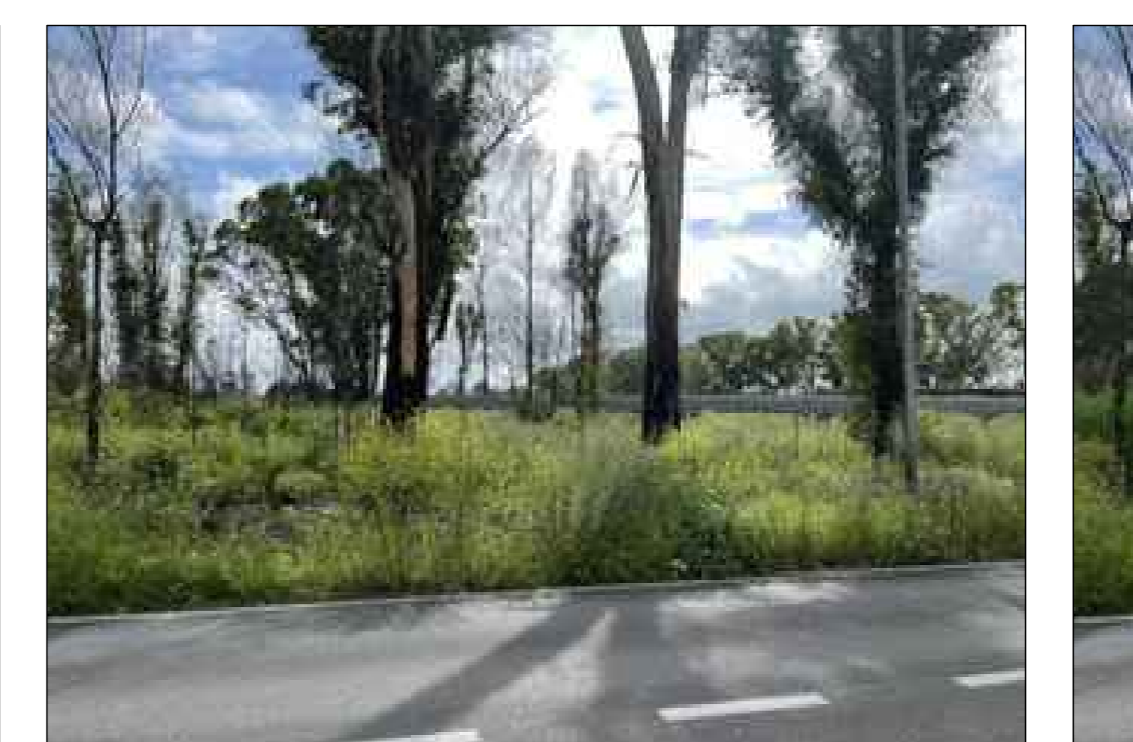
FOTO 5 - POST OPERAM con impianto
