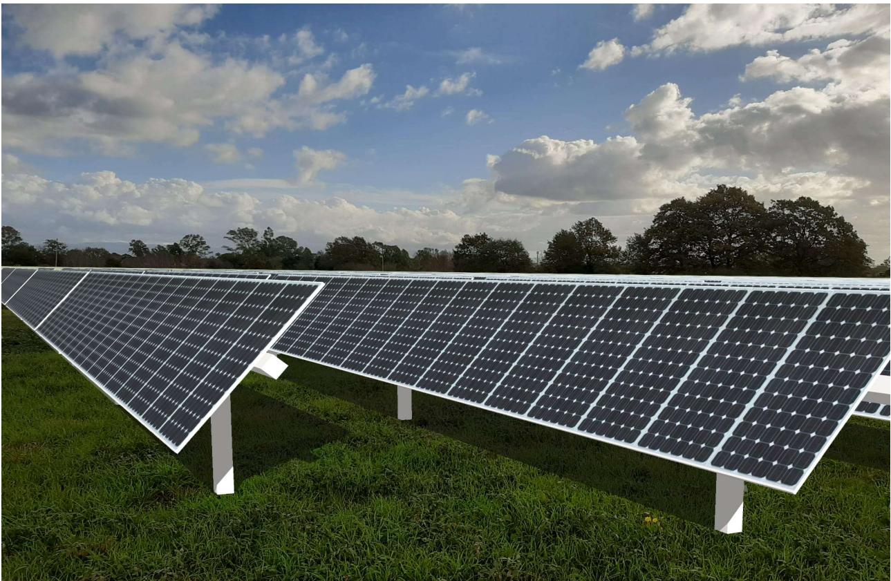
Figura 24 - visuale da sud post operam
