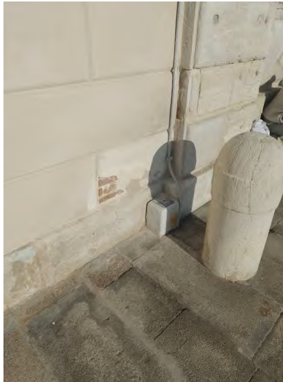
Figura 6: il caposaldo di riferimento Zero Mareografico di Punta della Salute (ZMPS)
