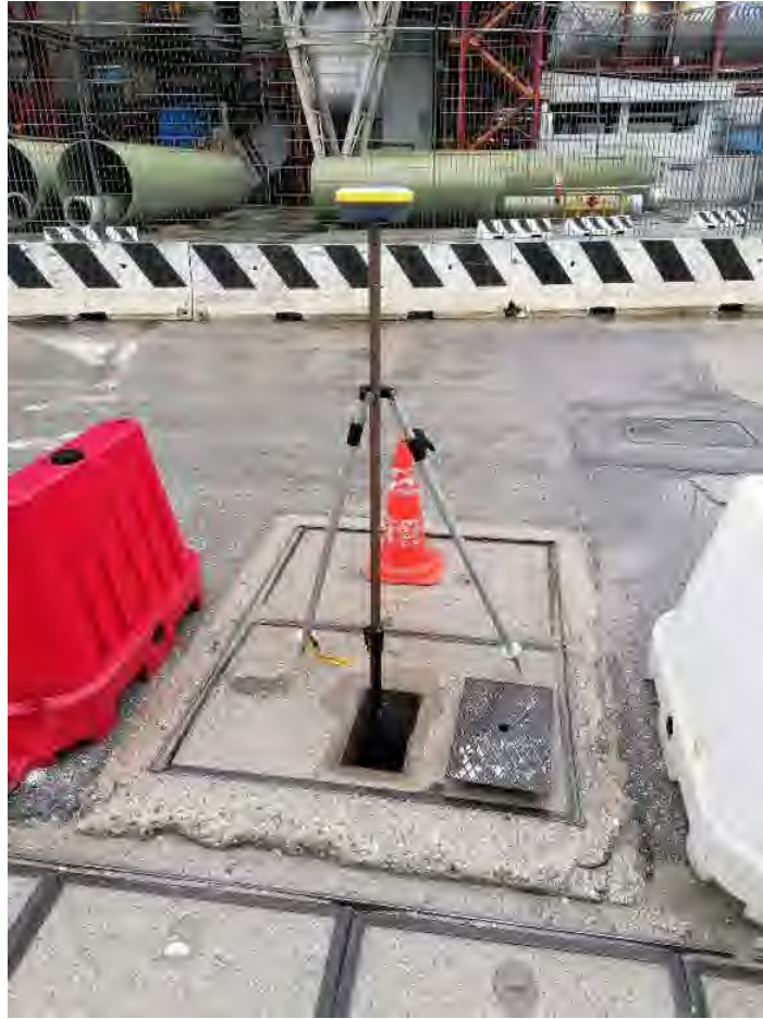
Figura 4: il pozzetto presso la Centrale termoelettrica "Andrea Palladio Fusina (VE) dove è ubicato il caposaldo di riferimento POZZO-B
