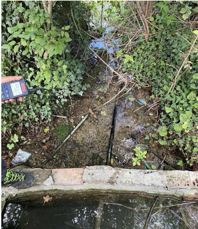
Figura 20 – Scarico verso il fosso Cetina della Sorg 01.
