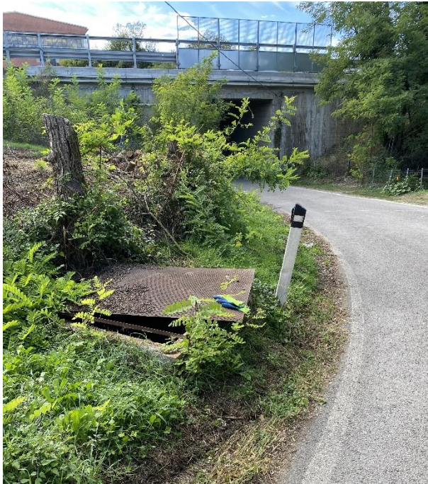
Figura 22 – Sorg.01 pozzo di accesso alla captazione.
