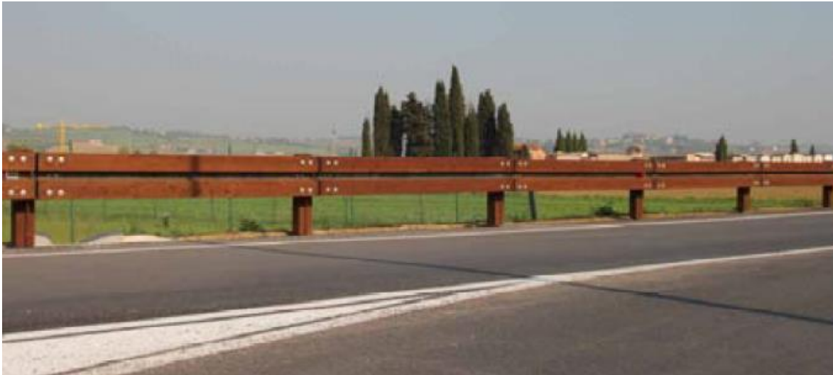
Figura 6.7 – Barriera in legno lamellare e acciaio corten
