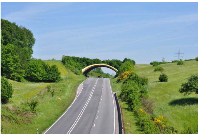
ecodotto sovra stradale
