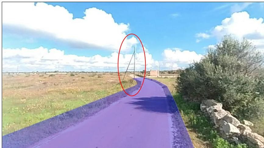
Lungo la 2. prima dell'intersezione con un'altra strada locale localizzata alle coordinate LAT.40.186973-LONG.18.101389, sono presenti, sul lato sinistro rispetto al senso di marcia "verso il lotto", una serie di sostegni in legno per linea telefonica (n.9 sostegni) che risultano attualmente in disuso, i cavi non sono presenti. Pertanto deve essere prevista la bonifica di tali sostegni per permettere le opere di ampliamento
