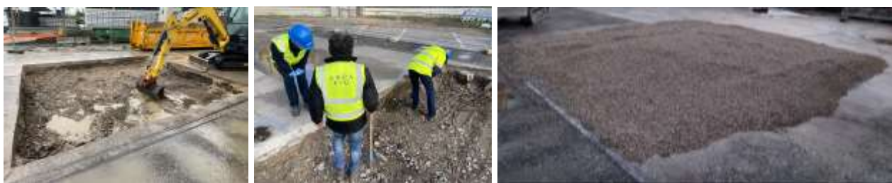
Figura 5-23: operazioni di MISE in corso, campionamenti pareti e fondo scavo S30 eseguiti in contraddittorio con ARPA FVG in data 14.12.2023 e richiusura dello scavo fatta il 19.01.2024
