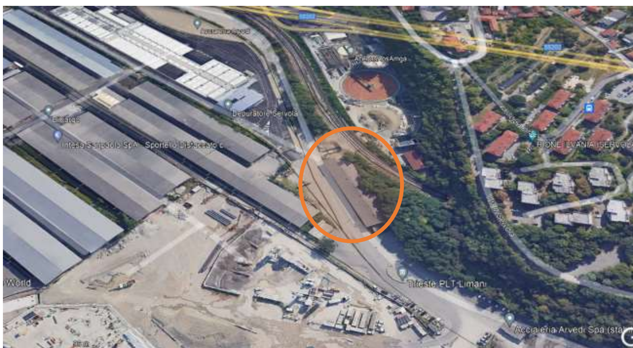
Figura 5-40 localizzazione del capannone da demolire per la realizzazione del rilevato ferroviario (nel tondo arancione)
