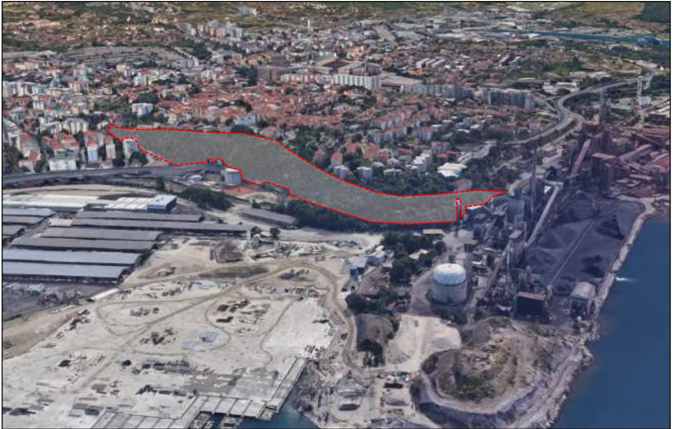
Figura 6-42 – Particolare dell’area d’attenzione, soggetta ad eventi franosi nella fascia a monte dell’area del vecchio depuratore di Servola
