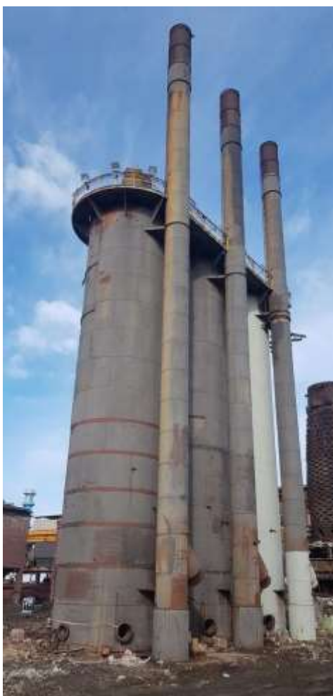
Figura 7-26 – Cowper AFO3; i due più scuri in primo piano, risalenti agli anni '20 del secolo scorso, verranno conservati e destinati a memoria dell'archeologia industriale (intervento futuro non oggetto del progetto in esame)
