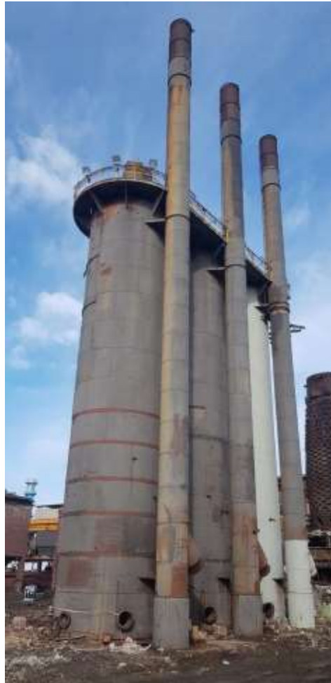
Figura 5-20: Cowper AFO3; i due più scuri in primo piano, risalenti agli anni '20 del secolo scorso, vanno conservati e destinati a memoria dell'archeologia industriale
