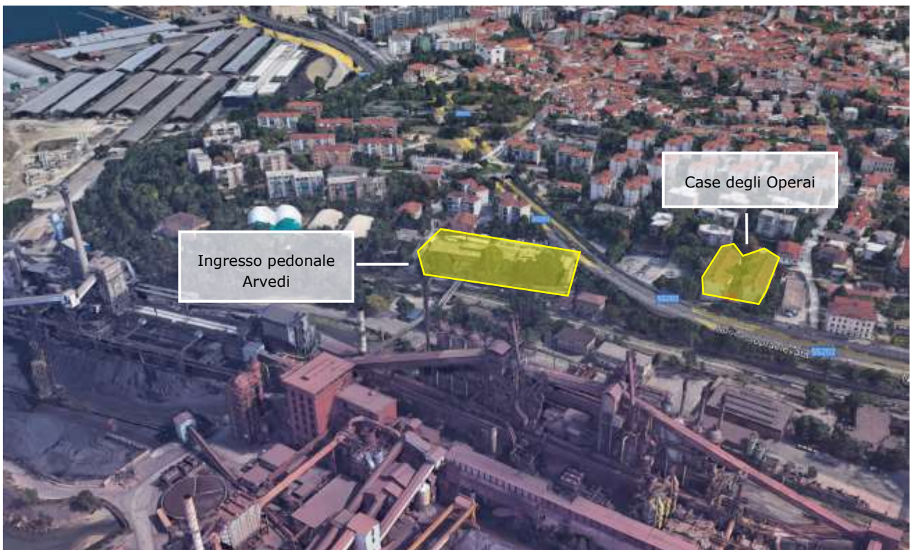
Figura 7-20 – Vista (pre demolizione dell'area a caldo della ferriera) dell'area del nuovo svincolo di raccordo con la GVT: in evidenza gli edifici che saranno demoliti
