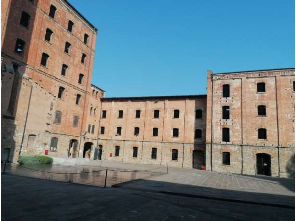
Figura 6-79 – Il cortile interno guardando la Sala delle croci (a destra) e la Sala delle 17 celle; recintato con una catena e segnalato con una piastra metallica a contrasto della pavimentazione lapidea l'ingombro del forno crematorio
