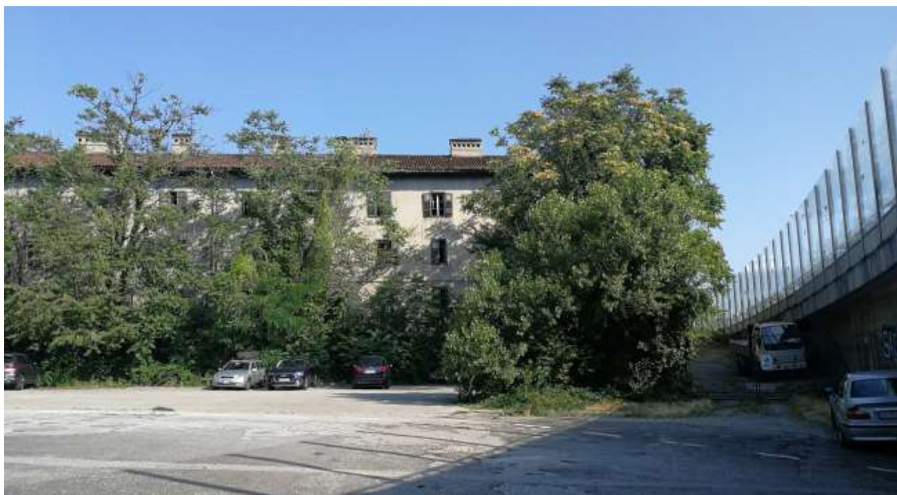
Figura 7-23 – Il Corpo Est delle due Case degli Operai, in completo stato di abbandono, che verranno demolite
