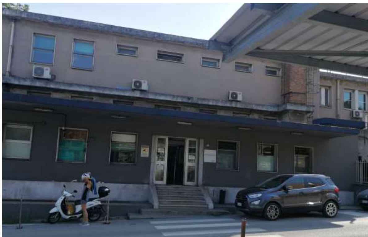
Figura 7-22 – L'edificio di ingresso alla Ferriera Arvedi, che verrà demolito, visto dal lato via San Lorenzo in Selva
