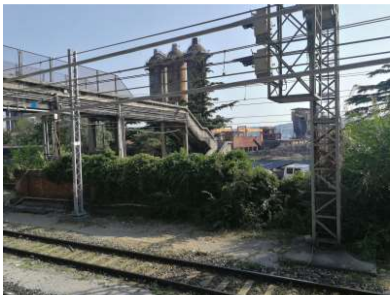
Figura 7-21 – Il Passaggio pedonale che supera i binari ferroviari dello scalo e conduce all'area produttiva della Ferriera
