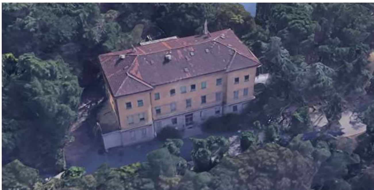
Figura 7-24 Vista da Google Earth della Palazzina Direzionale all'interno della quale verrà allestito il Museo dell'Archeologia Industriale
