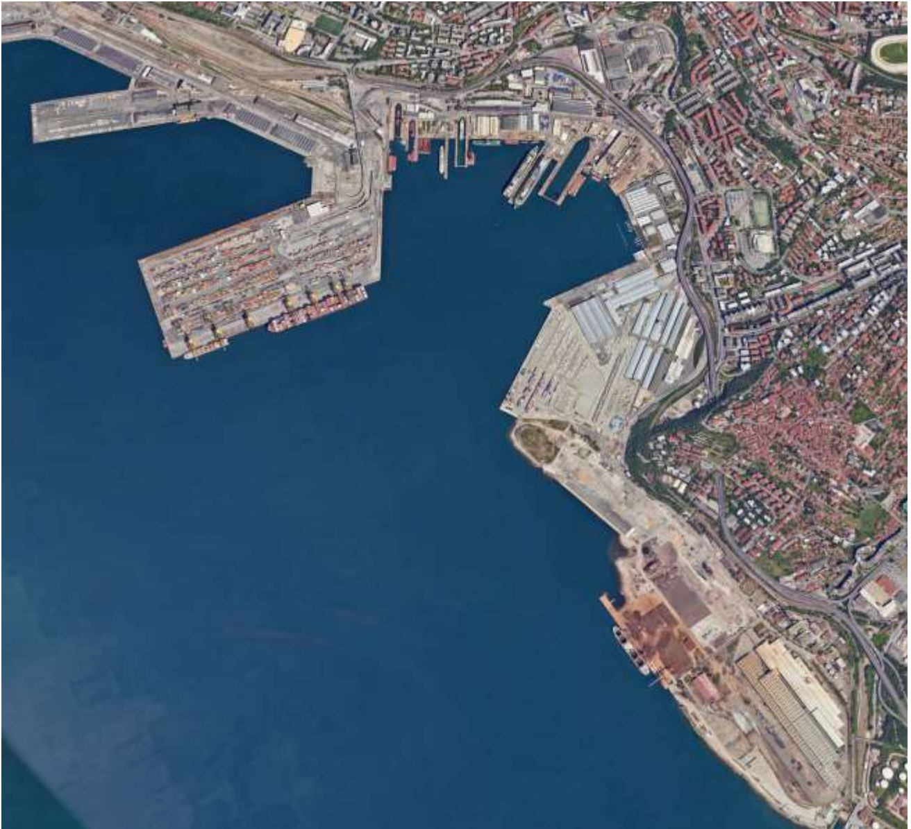
Figura 7-34 – Vista dall’alto della banchina del Molo VII (al centro) e dell’area interessata dai lavori del progetto in esame (immagine da Google Earth)
