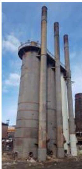
Figura 6-21: Cowper AFO3; i due più scuri in primo piano, risalenti agli anni '20 del secolo scorso, verranno conservati e destinati a memoria dell'archeologia industriale (intervento futuro)
