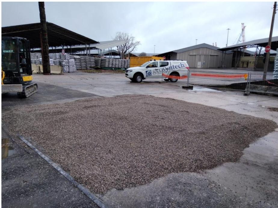
Figura 14: Chiusura scavo dopo esiti analitici e comunicazione ad ARPA e RAFVG
