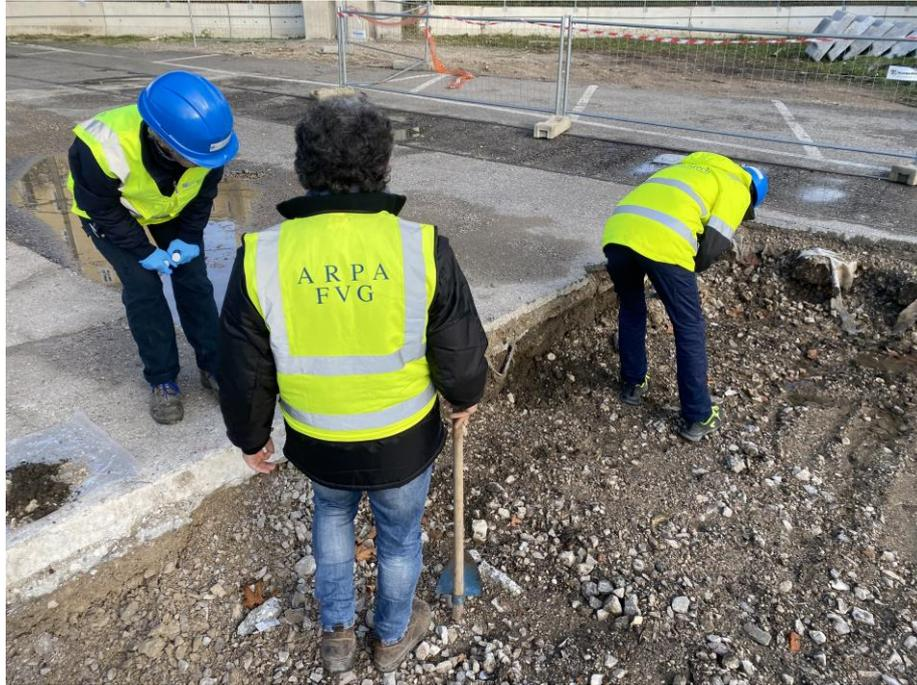
Figura 13: Campionamenti pareti e fondo scavo S30 eseguiti in contraddittorio con ARPA FVG in data 14 dicembre 2023
