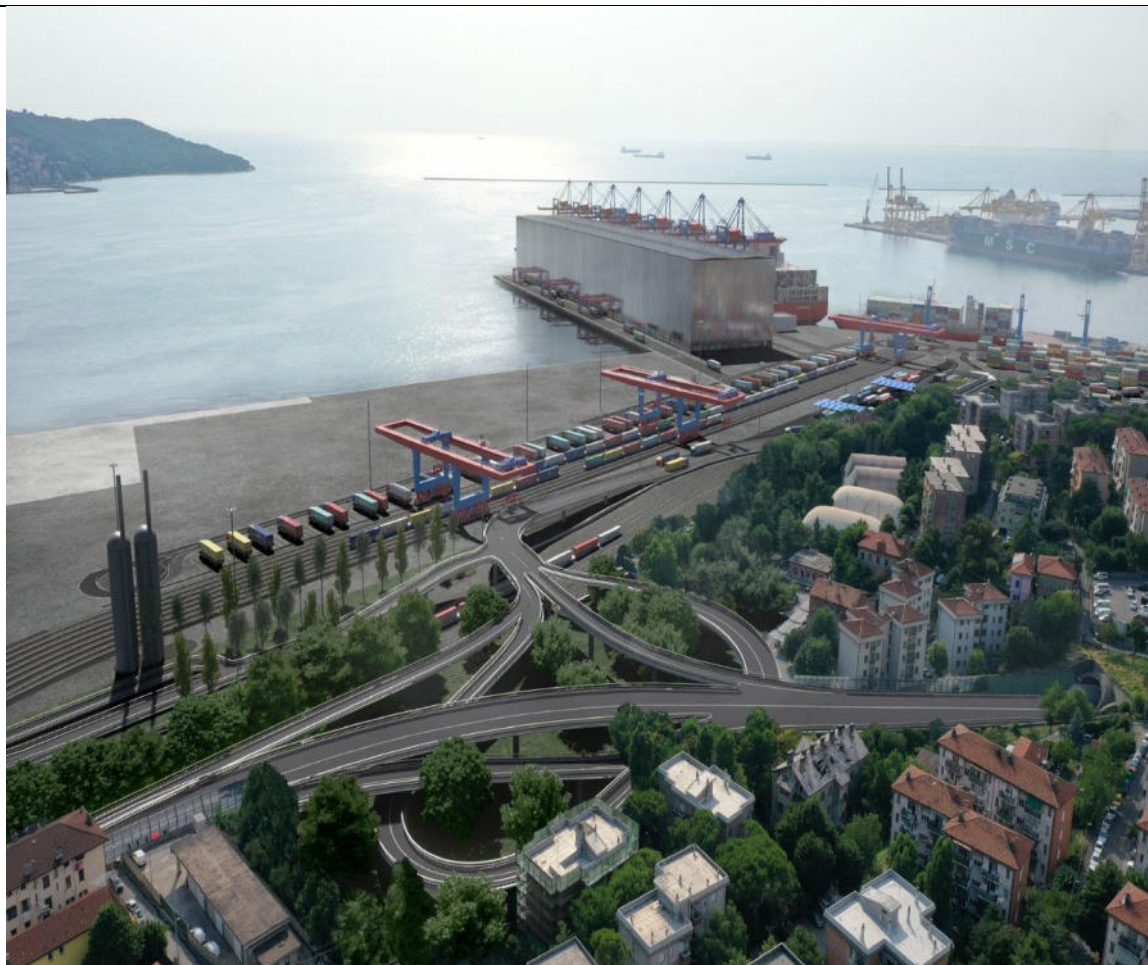
Figura 6-3. Area del nuovo svincolo viabilistico ante e post intervento
