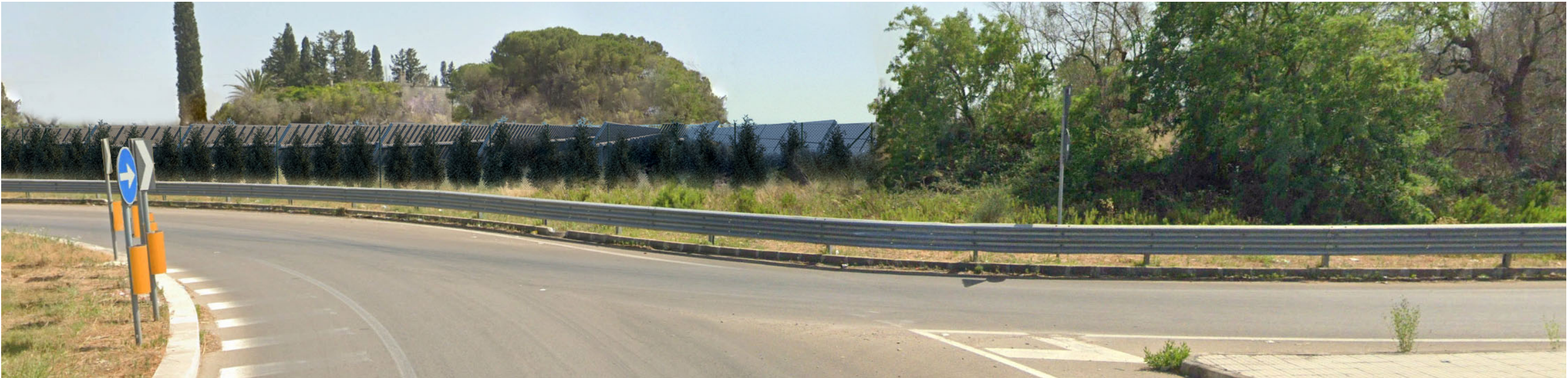
105 - POST-OPERAM (vista 180 gradi rispetto al Nord)
