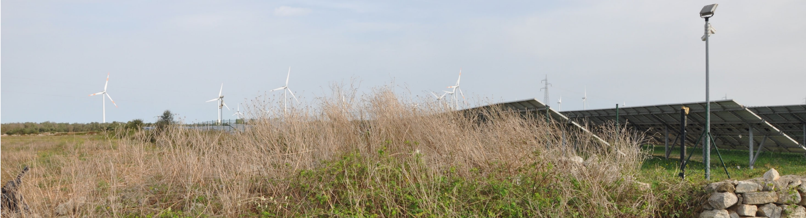
001_1 - ANTE-OPERAM (vista 80 gradi rispetto al Nord)
