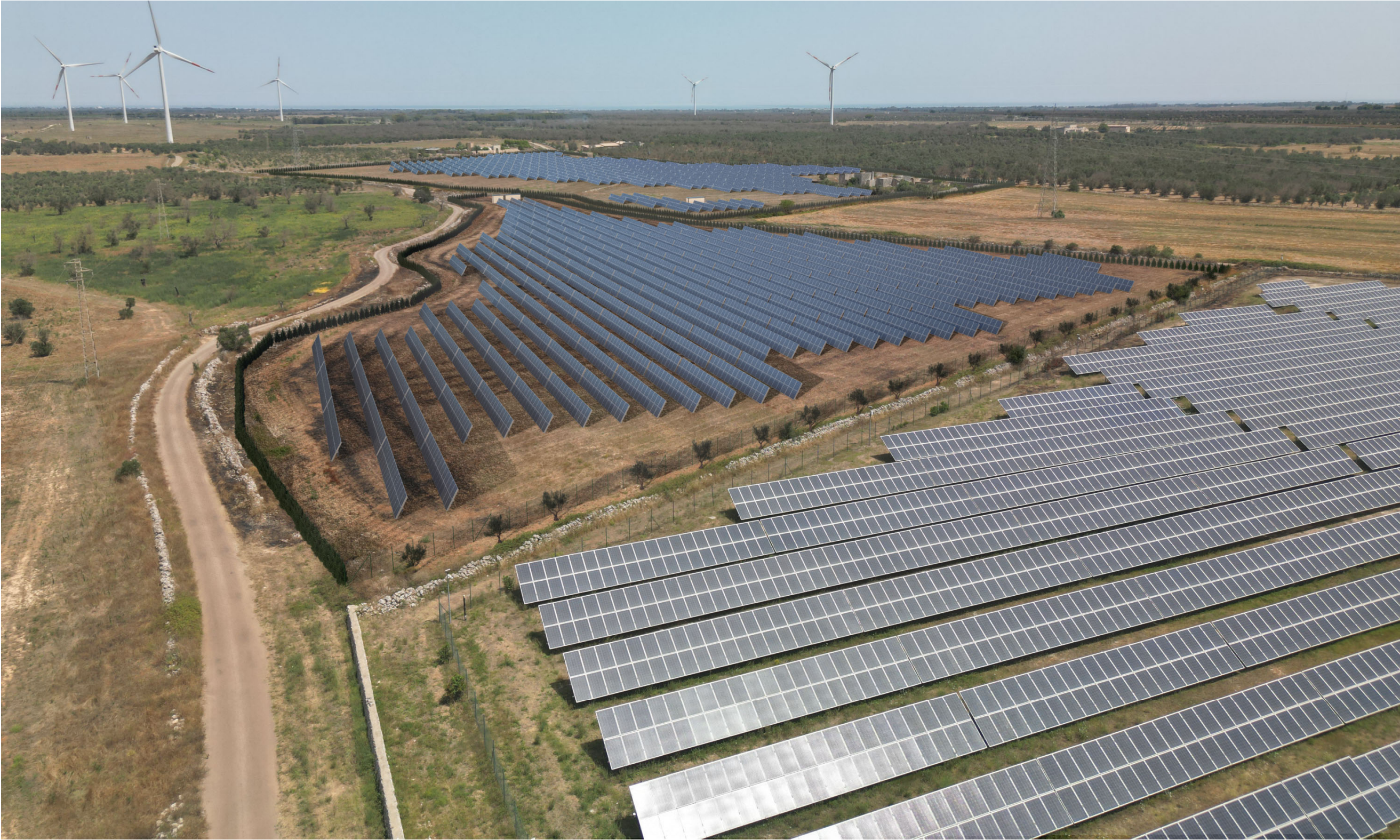
B - POST-OPERAM (vista 15 gradi rispetto al Nord)
