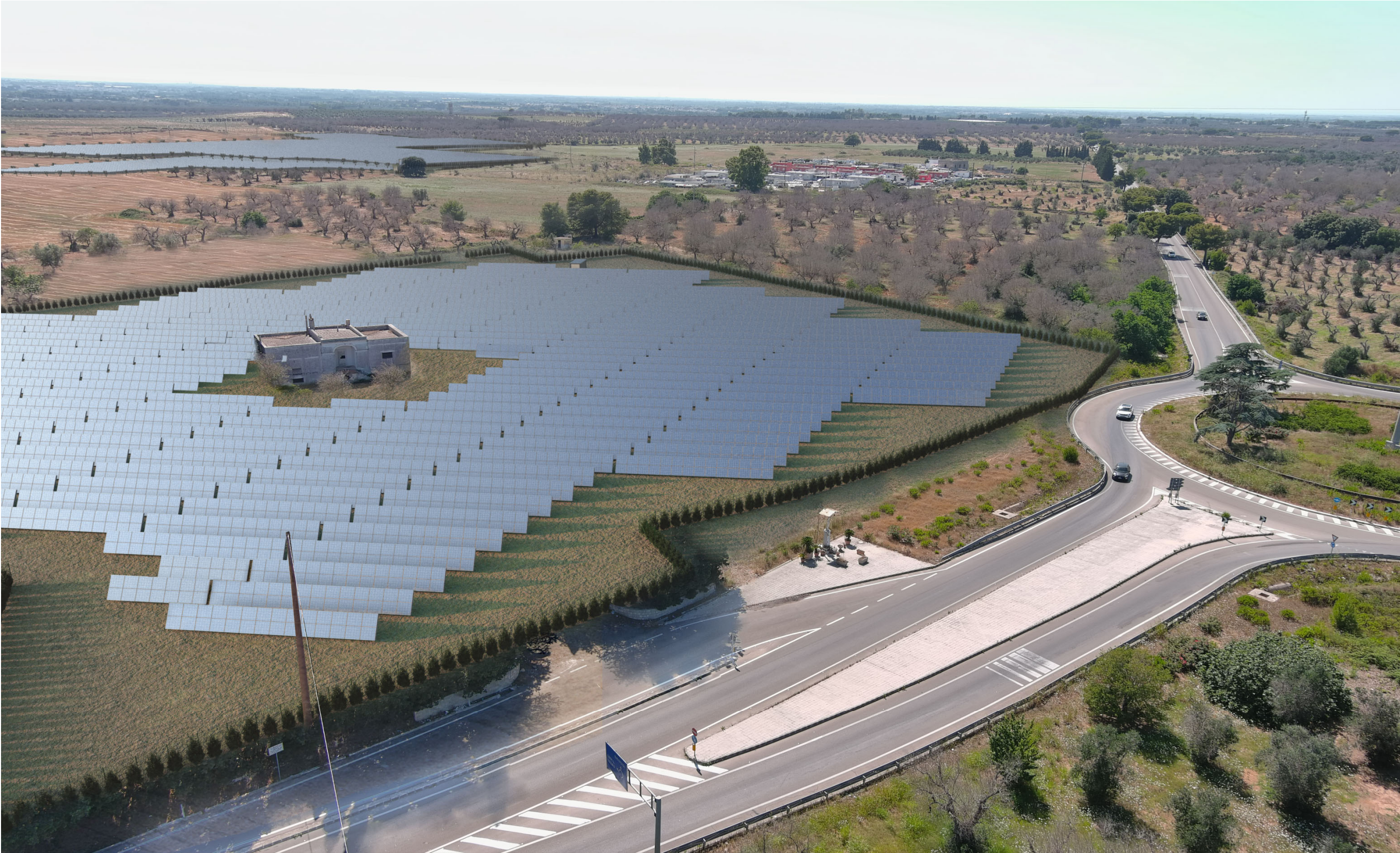
C - POST-OPERAM (vista 270 gradi rispetto al Nord)
