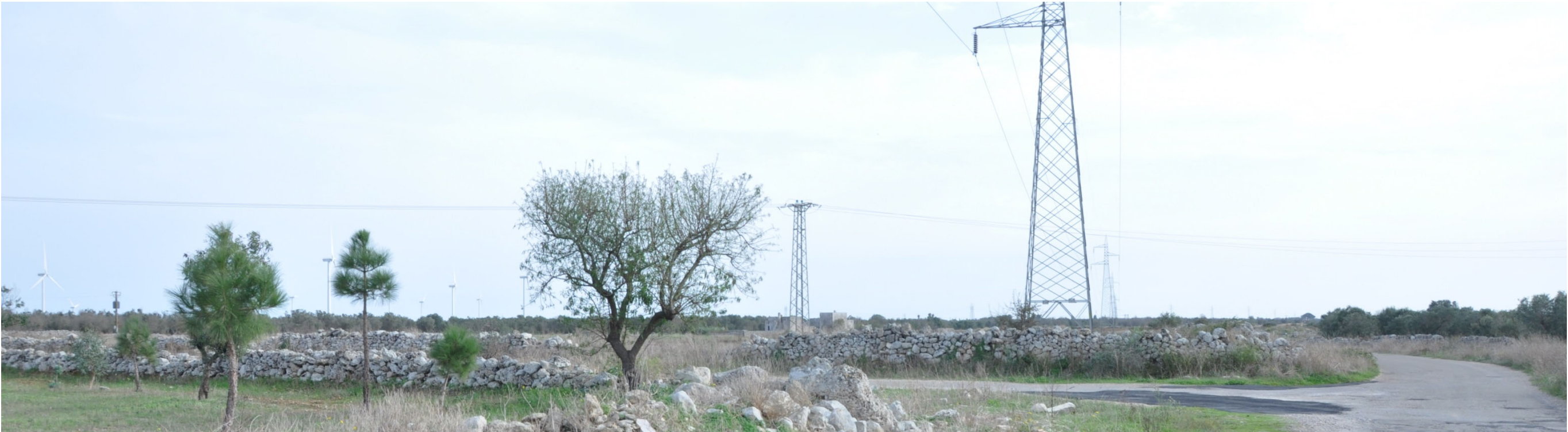
004_2 - ANTE-OPERAM (vista 165 gradi rispetto al Nord)
