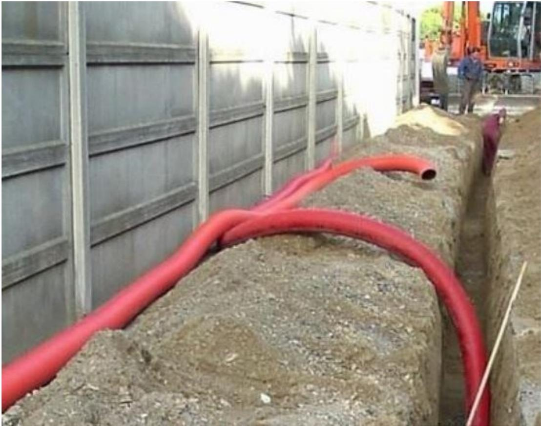
**Figura 10 - scavo per elettrodotti interrati**
