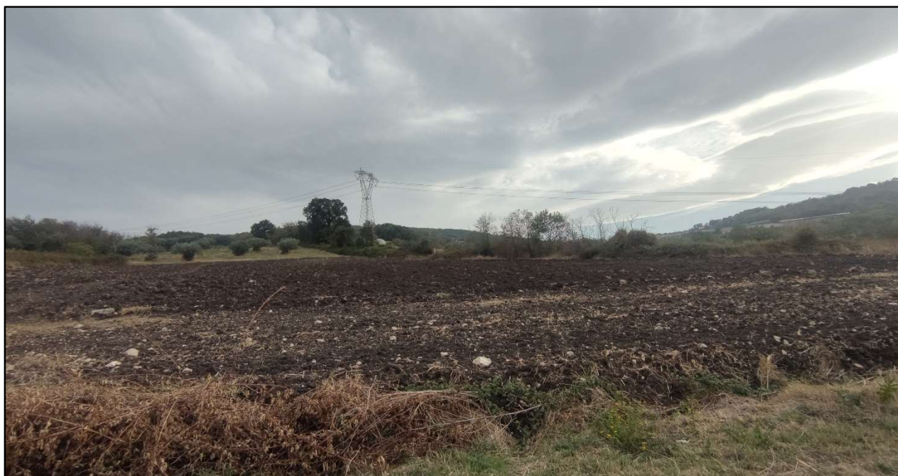
Foto 13.14: Linea AT 380 kV “Larino Gissi” su cui realizzare l’entra/esci della nuova stazione SE RTN 380/150/36 kV
