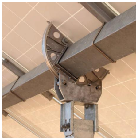
figura 8: schema nodo trave continua / colonna
