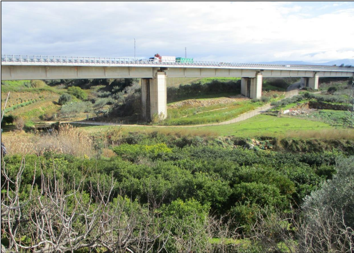
Comune di Menfi. Attraversamento del Torrente Finocchio. Ambito 10, Provincia di Agrigento, Paesaggio Locale 1 "Menfi".
