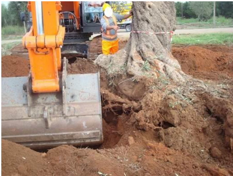
Figura 5.1/A: scalzamento zolla
