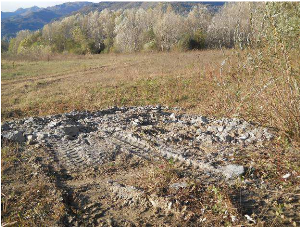
7-8. I sondaggi geognostici ormai ricolmati: il materiale di riempimento è ghiaia e clasti lapidei eterometrici.
