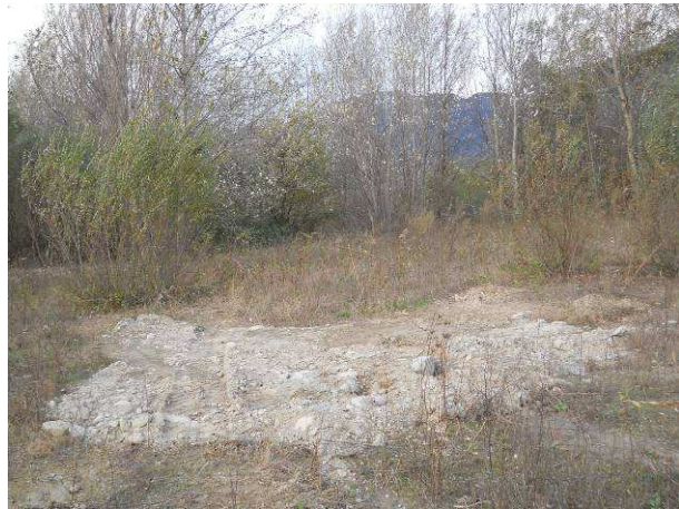
7-8. I sondaggi geognostici ormai ricolmati: il materiale di riempimento è ghiaia e clasti lapidei eterometrici.
