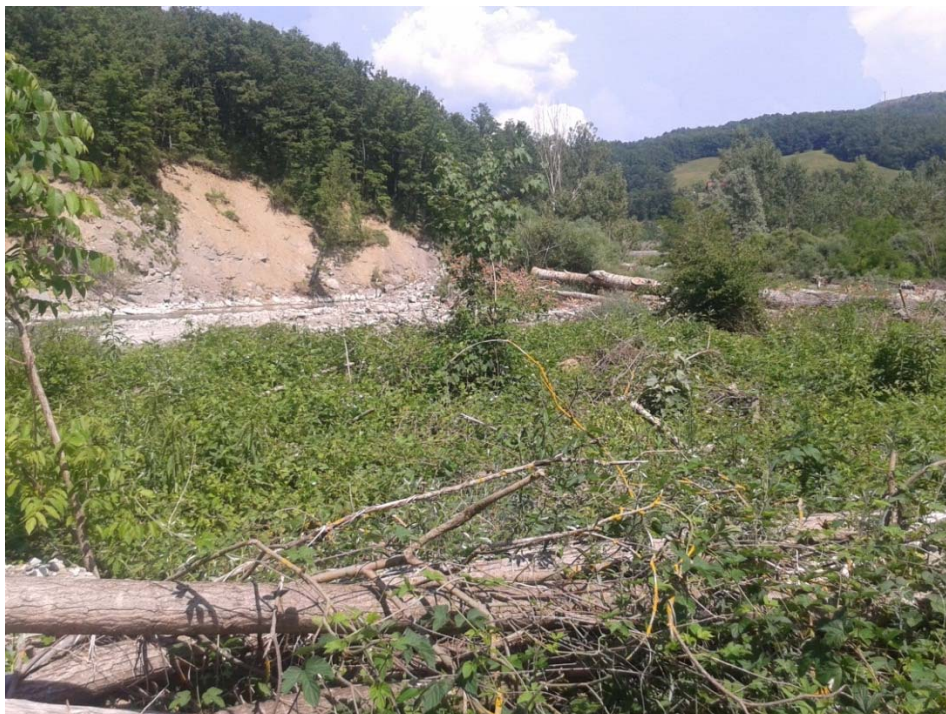
Foto 4.1/A: lavori in area golenale rilevati nel mese di Giungo 2013. Sullo sfondo l'area di uscita del microtunnel
