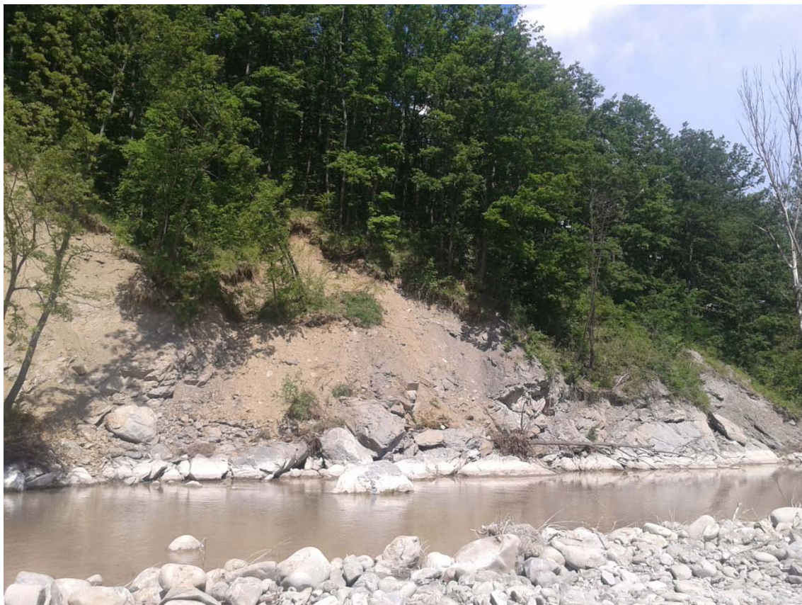
Foto 2.2/A: zona di uscita del microtunnel in cui si può notare la presenza di affioramenti litoidi sulla sponda e in alveo, di notevoli dimensioni
