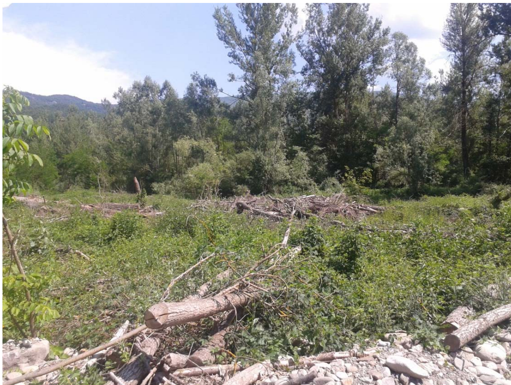
Foto 4.1/C: lavori in area golenale rilevati nel mese di Giugno 2013 – seguito
