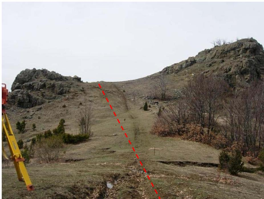
**Figura 3.2/A: Panoramica del rilievo ofiolitico Colle Il Castellaccio attraversato in sotterraneo. La linea rossa rappresenta il tracciato in progetto.**
