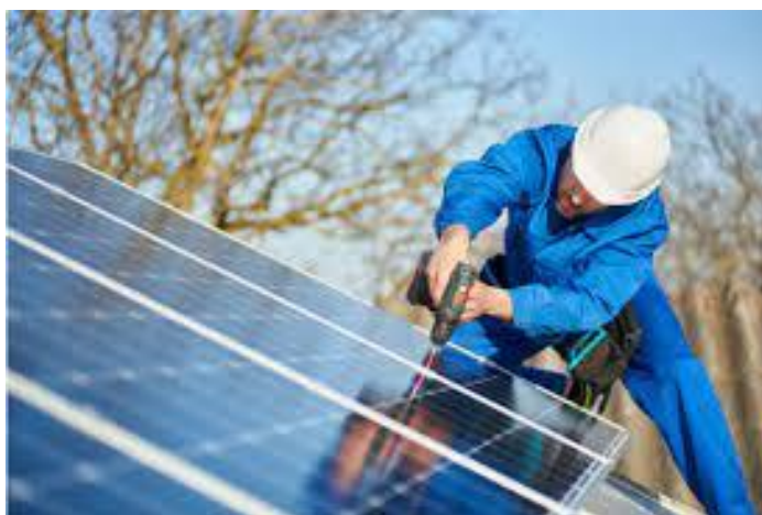
Figura 31: Fissaggio dei moduli fotovoltaici
