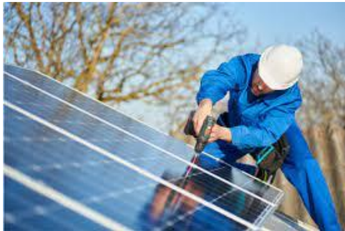
Figura 4: Fissaggio dei moduli fotovoltaici
