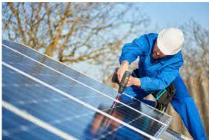
Figura 4.17: Fissaggio dei moduli fotovoltaici
