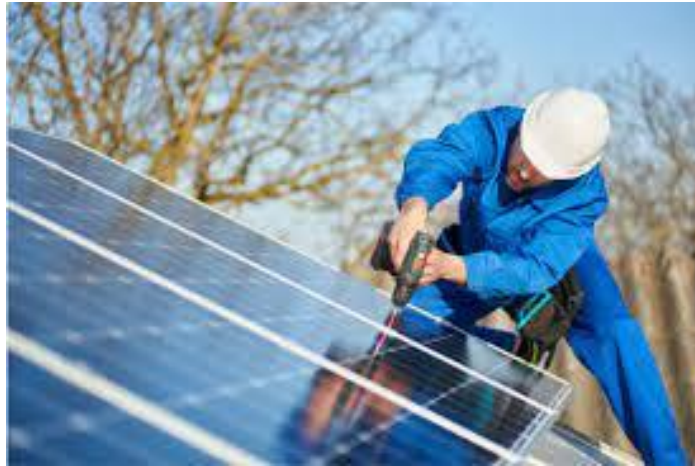
Figura 4.17: Fissaggio dei moduli fotovoltaici
