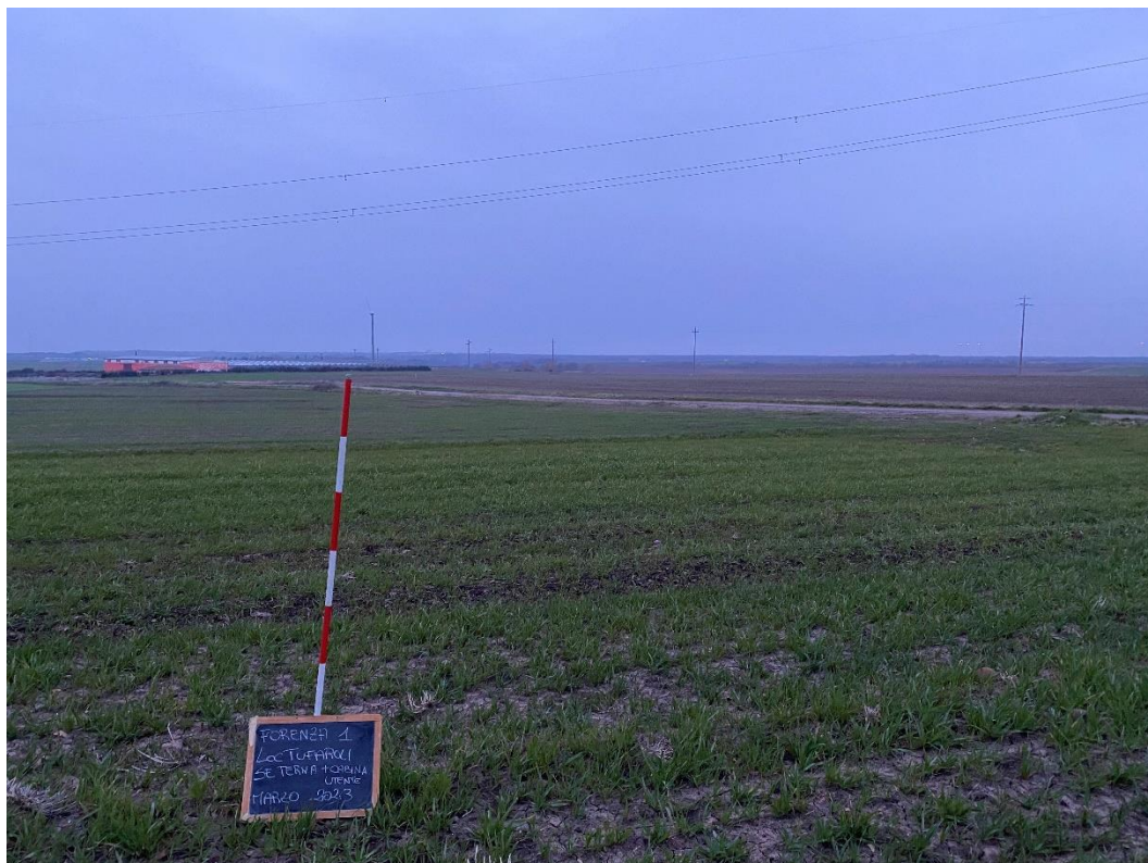
Foto 2. Mass.a Lopomo. Sottostazione Terna – Cabina utente.
