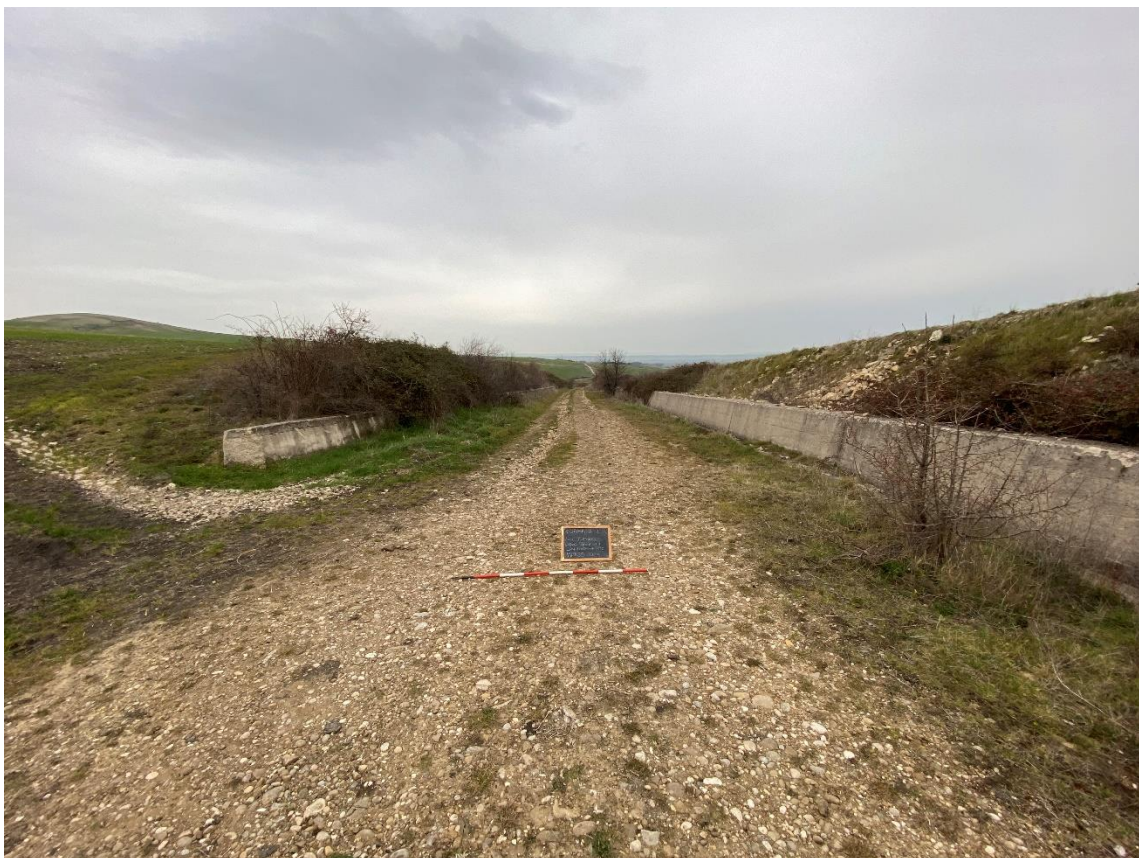
Foto 6. Cavidotto esterno - tratto in TOC.
