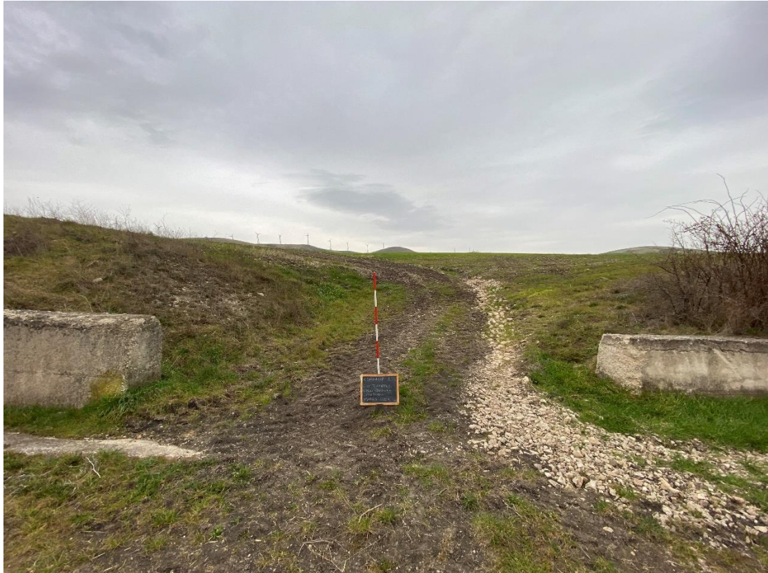
Foto 5. Cavidotto esterno e area dei pannelli.
