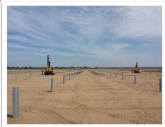
Figura 6.6. – Foto esempio di impianti realizzati con stessa struttura e stessi moduli fotovoltaici.
