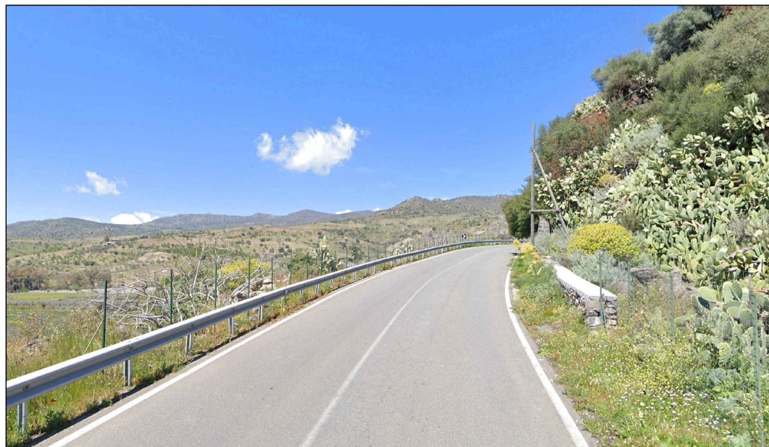
Veduta dalla S.S. 284 in direzione est - Stato di fatto
