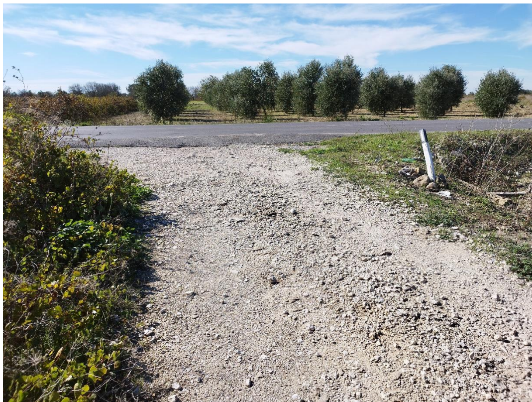
Foto 14: Viabilità principale SS605, ingresso alla viabilità secondaria
