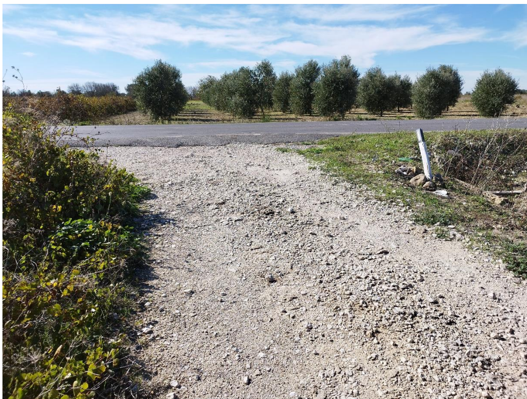
Foto 14: Viabilità principale SS605, ingresso alla viabilità secondaria
