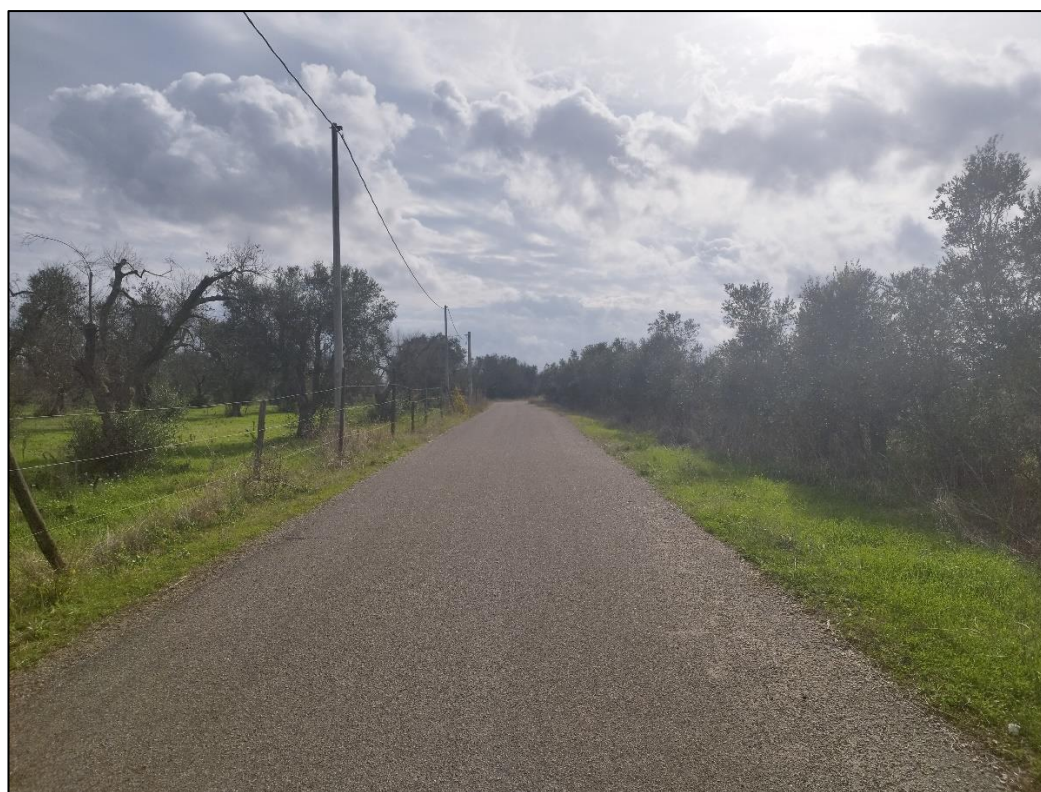
Foto 10: Contrada pisciani, verso le aree di impianto della TR04
