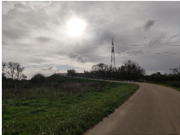
Ponte sulla SS613
