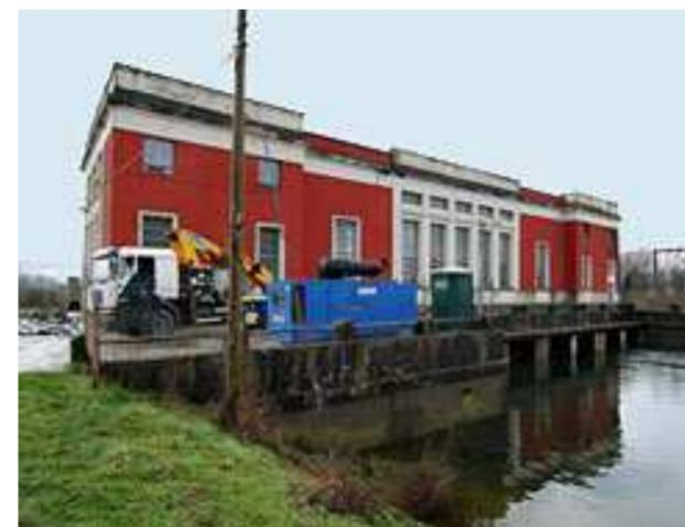
Figura 12 - Consorzio di bonifica di Rieti. Veduta della sede dell'impianto idrovoro, nei pressi del lago Ripasottile, utilizzato per il sollevamento e lo scarico dei deflussi della piana reatina, nel fiume Velino <http://www.archivioluca.com>
