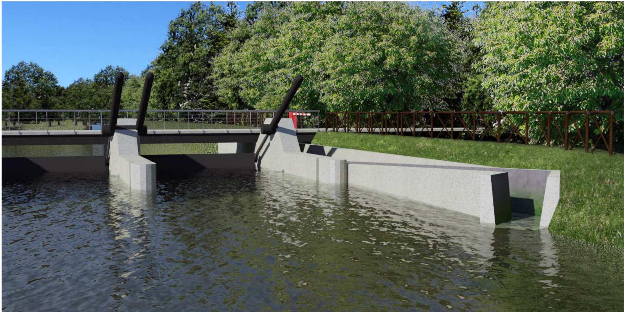
Figura 48 – Render: vista da monte – imbocco del canale di continuità biologica
