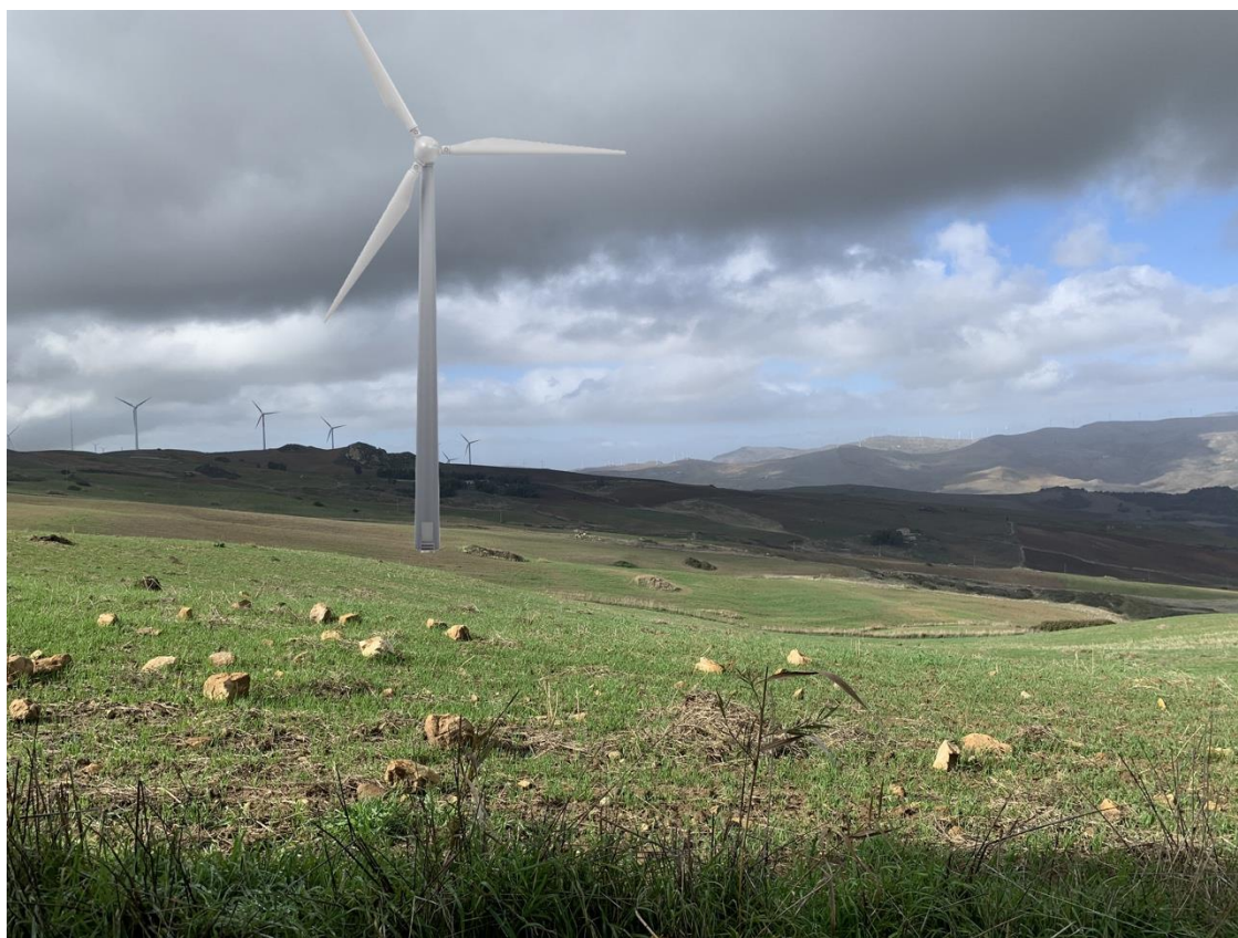
Punto di ripresa n.8 - WTG CVT_E12
