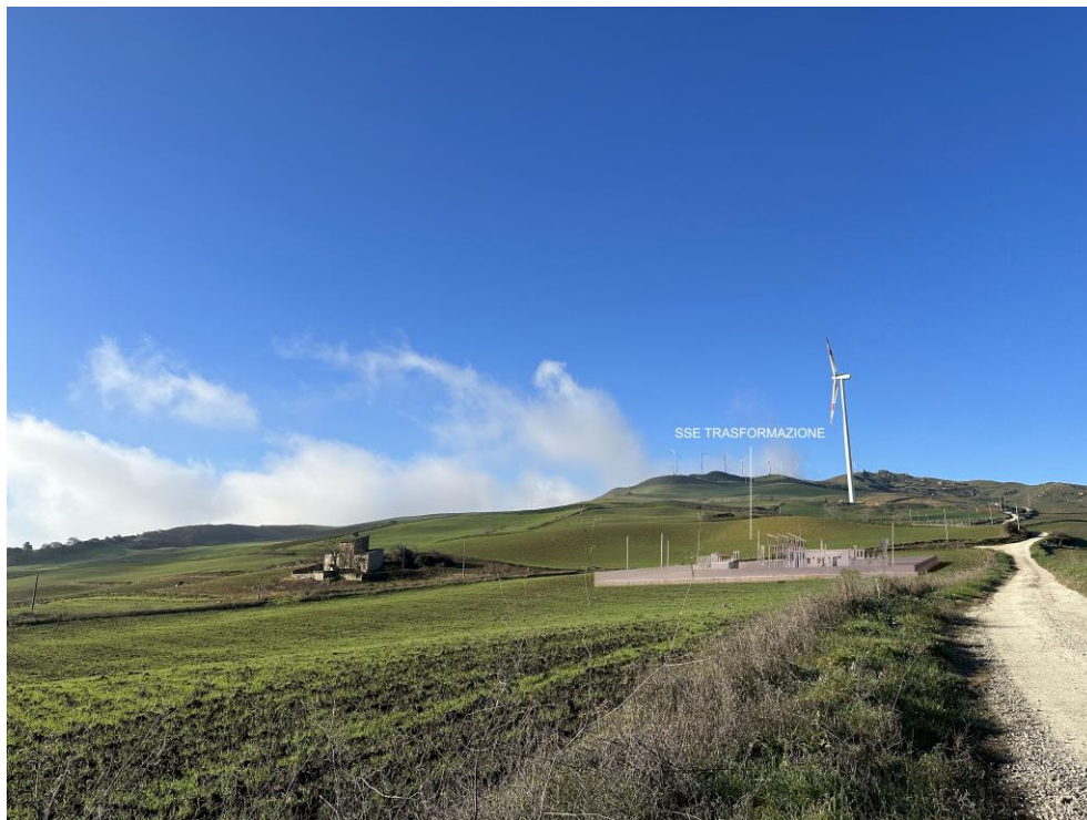
Punto di ripresa da terra n.1 (Sottostazione di trasformazione 150/33 kV)
