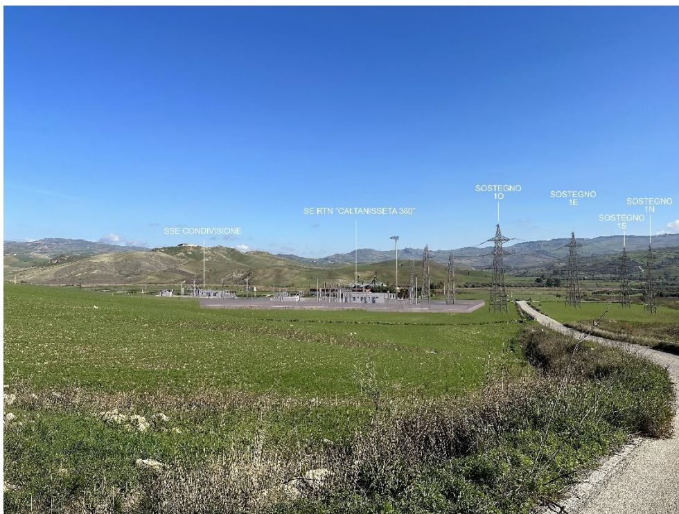
Punto di ripresa da terra n.4 (Raccordi elettrodotto Chiaramonte Gulfi – Ciminna)
