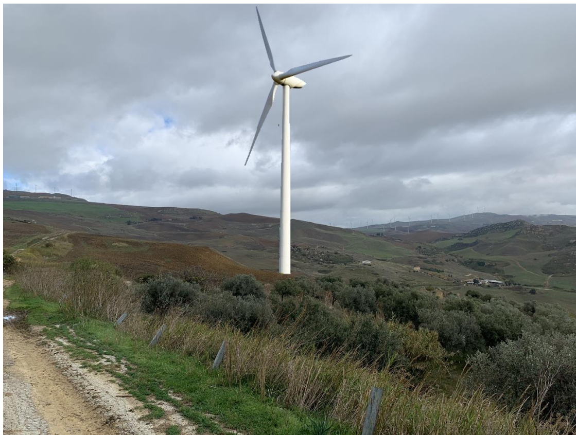
Punto di ripresa n.15 - WTG CVT_E18
