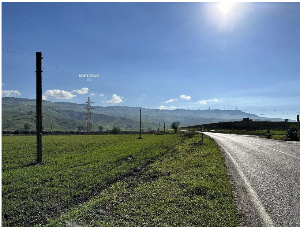
Punto di ripresa da terra n.4 (SE RTN "CALTANISSETTA 380 kV")
