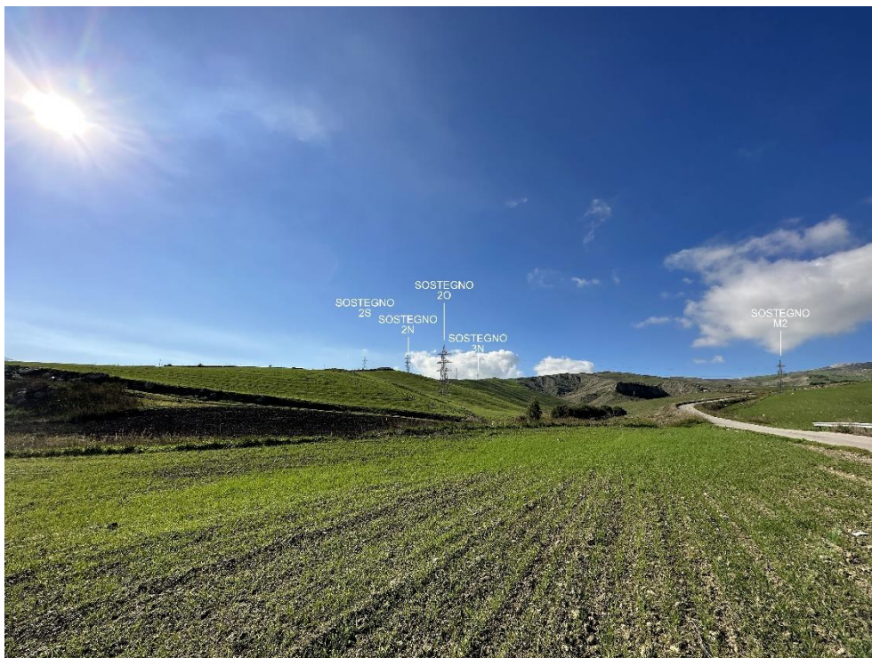
Punto di ripresa da terra n.1 (Raccordi elettrodotto Chiaramonte Gulfi – Ciminna)
