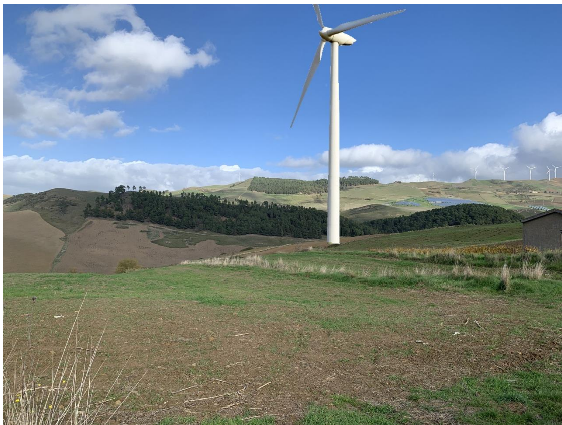
Punto di ripresa n.9- WTG CVT_E13
