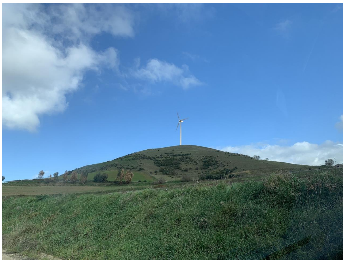
Punto di ripresa n.7- WTG CVT_E11
