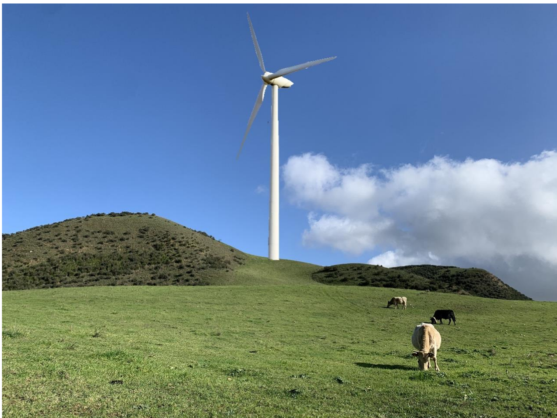
Punto di ripresa n.6 - - WTG CVT_E010
