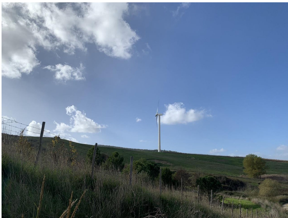
Punto di ripresa n.10 - WTG CVT_E14
