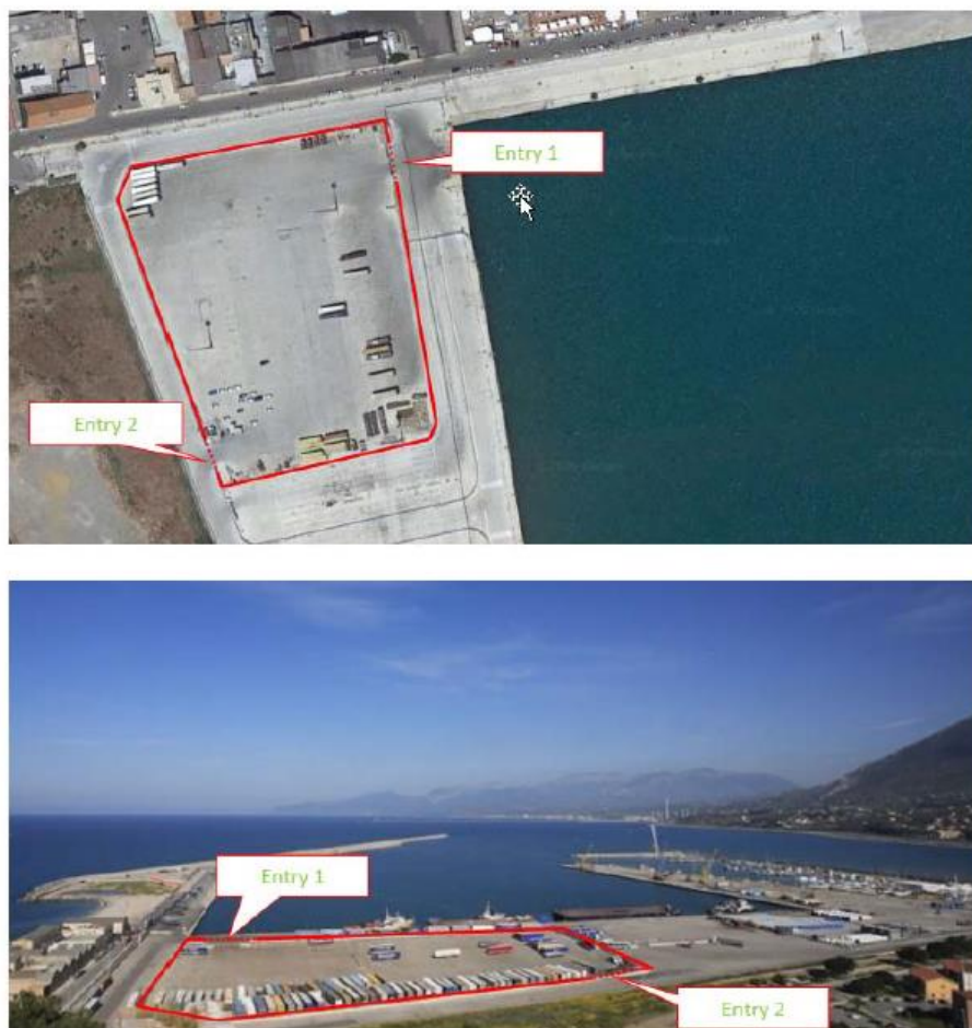
Figura 4-2: Area stoccaggio nei pressi del porto
