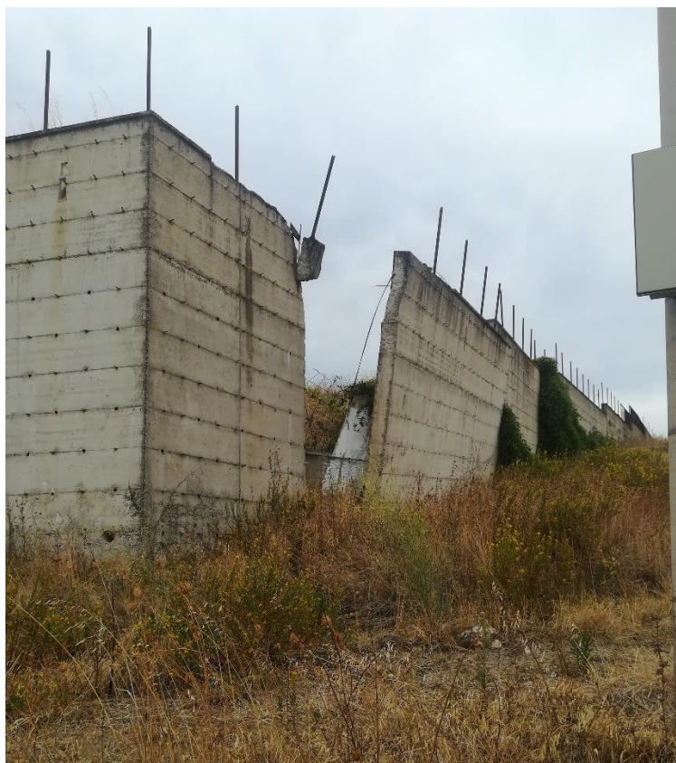
Figura 13: Vista ovest dei manufatti da demolire nel lotto 3, particolare della recinzione in decadimento
