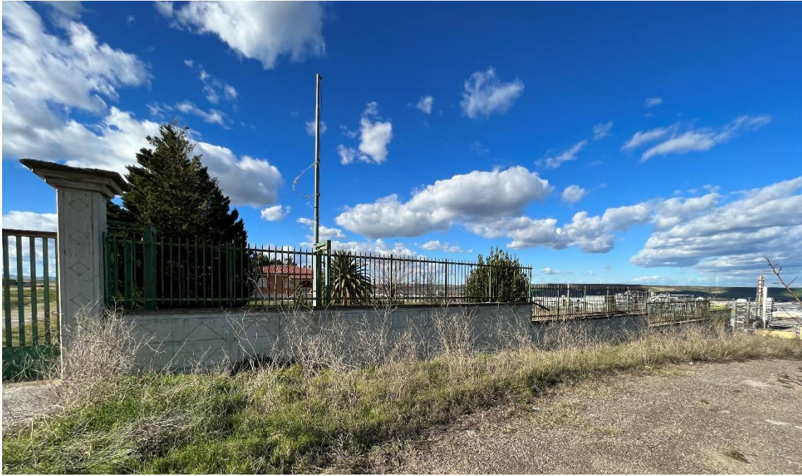
Figura 11: Vista est dei manufatti da demolire nel lotto 3
