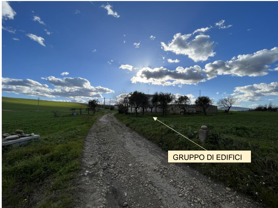
Figura 7: Rustico da demolire nel lotto 1, vista nord
