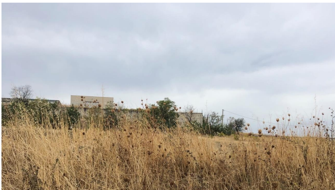
Figura 10: vista nord dei manufatti da demolire nel lotto 3
